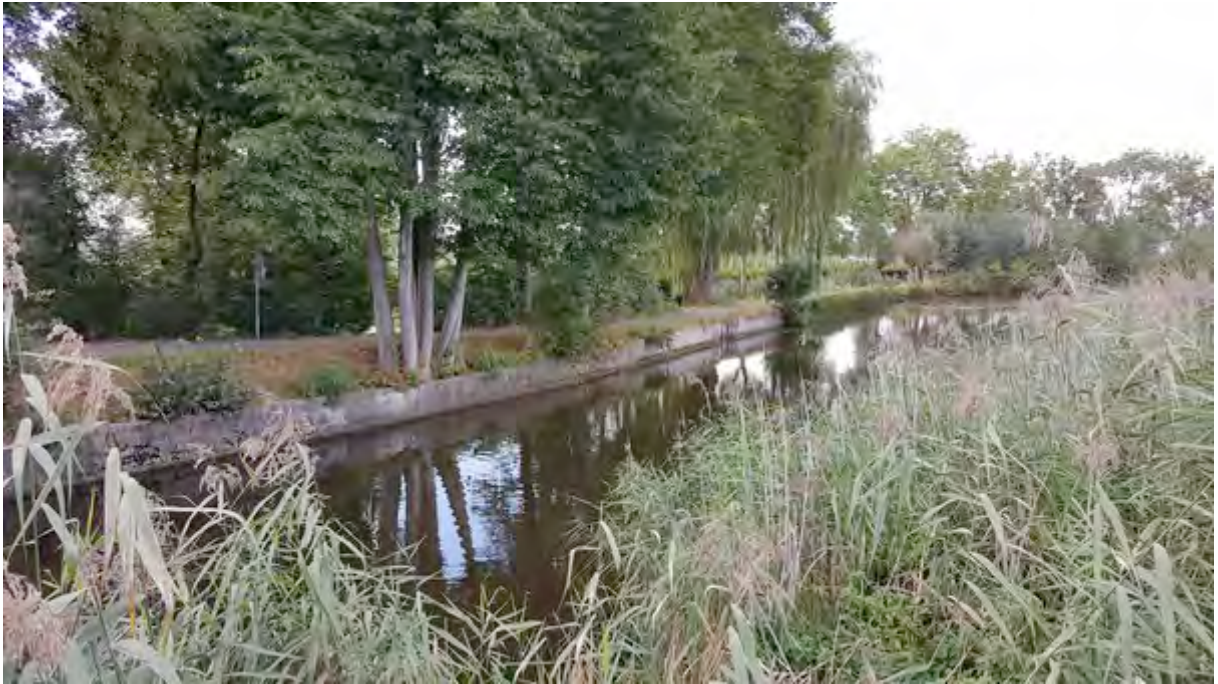
Overgang van de oever van de Giessen met oeverbeplanting naar betonnen grondkeringsconstructie
