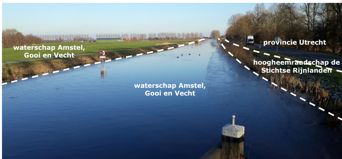
Afbeelding 5: De linkerkade en watergang is in beheer van Waterschap Amstel, Gooi en Vecht. De rechterkade is in beheer van Hoogheemraadschap de Stichtse Rijnlanden. De provinciale weg N463 is in eigendom en beheer van provincie Utrecht (bron: HDSR, 2018)
