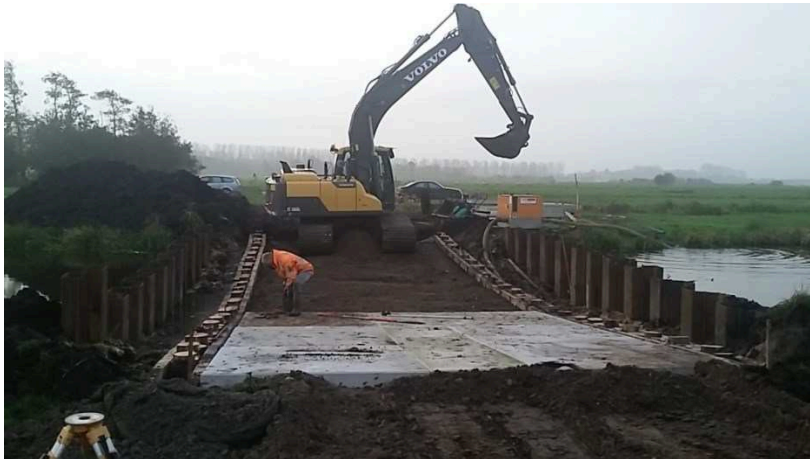
Figuur 8.1 Aanleg onderwaterdam in polder Bloemendaal
