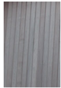
Houten gevel, staande onbehandelde delen
