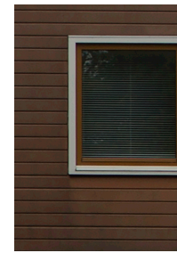
Houten gevel, liggende behandelde delen
