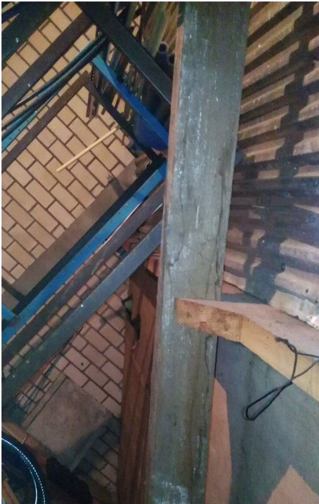
Figuur 5 Gording en spant ter plaatse van steile dakvlak schuur (woningzijde).
