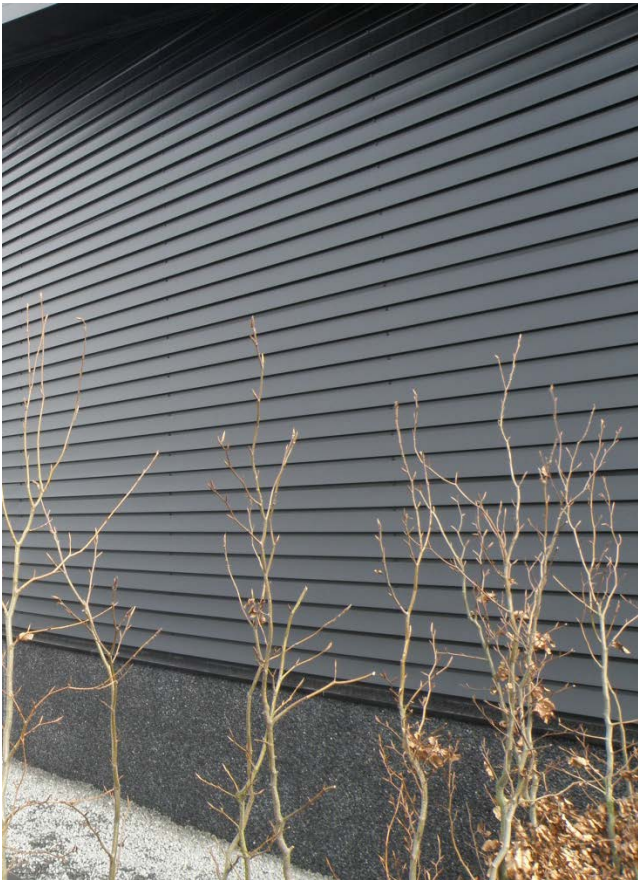
(gevel bekleding potdekselwerk)
