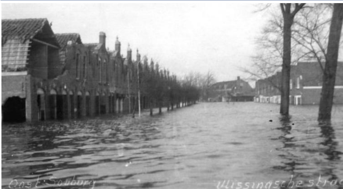
Figuur 18: Een foto uit 1945 van de Vlissingsestraat huisnummers 144 en 146 (in de oorlog 148). De woningen hebben schade als gevolg van oorlogsgeweld.
