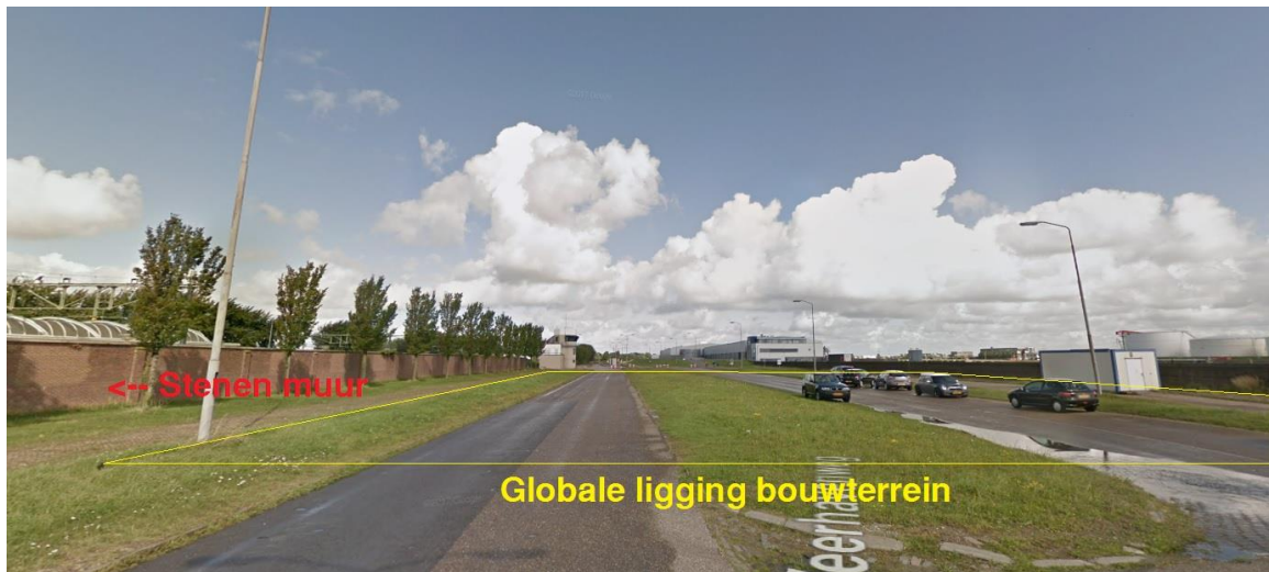
Afbeelding 4.1 Globale ligging bouwterrein en stenen muur ter afscheiding van het spoor
