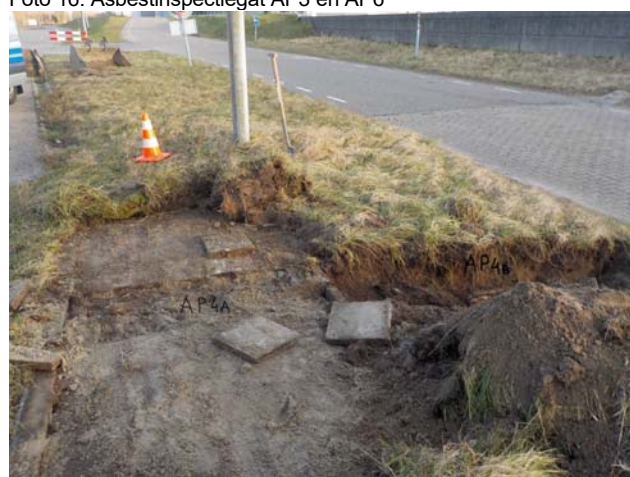
Foto 18: Asbestinspectiegat AP4a en AP4b
