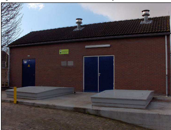
Figuur 5: Gemaal Boezemloozende door Strijensas.
