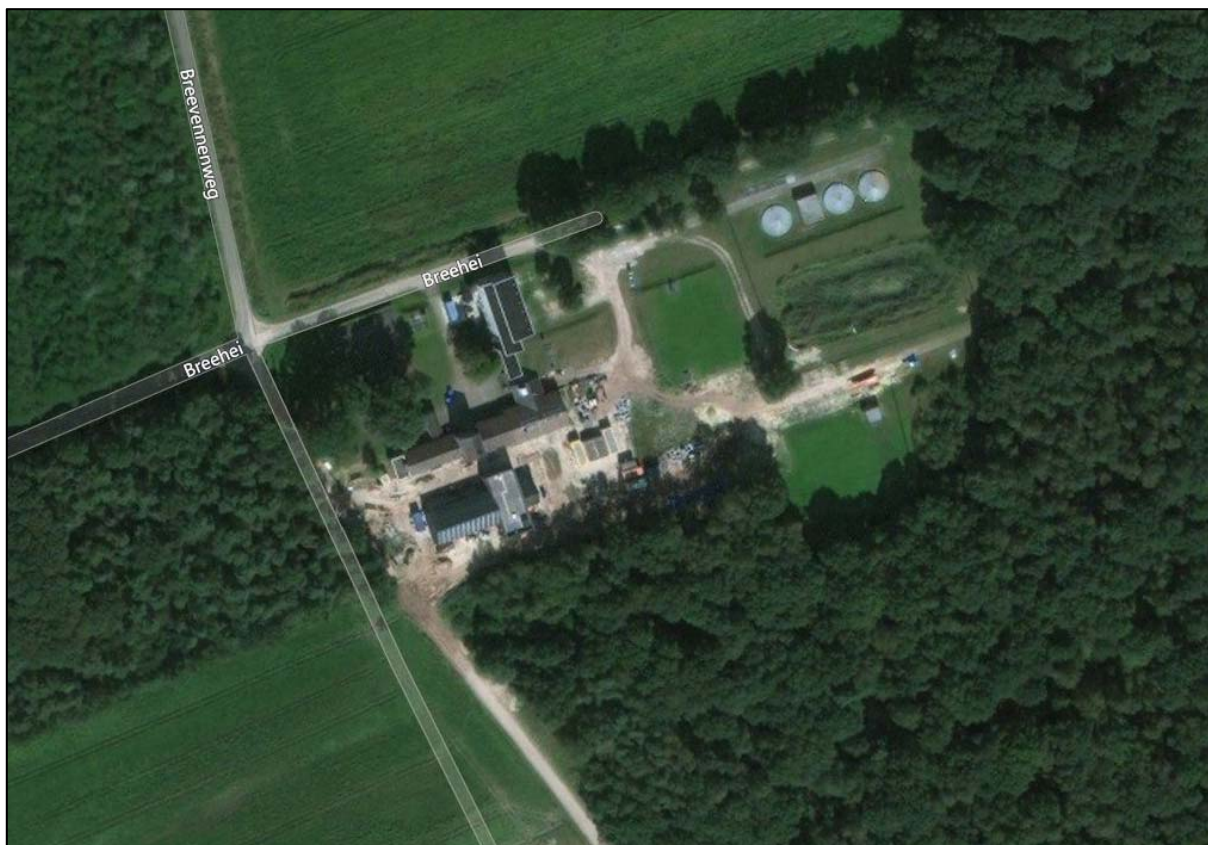
Figuur 3.1: pompstation Breehei, Breevennenweg 11 te Leunen (luchtfoto: Bing Maps)
