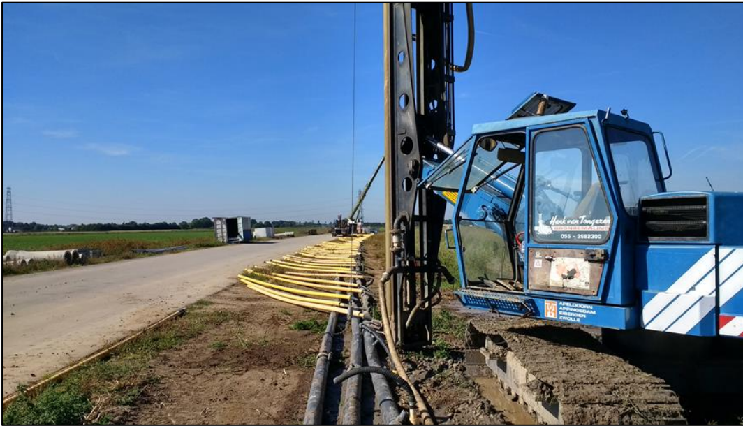
Figuur 8: Aanbrengen zwaartekrachtbemaling middels spuitboren
