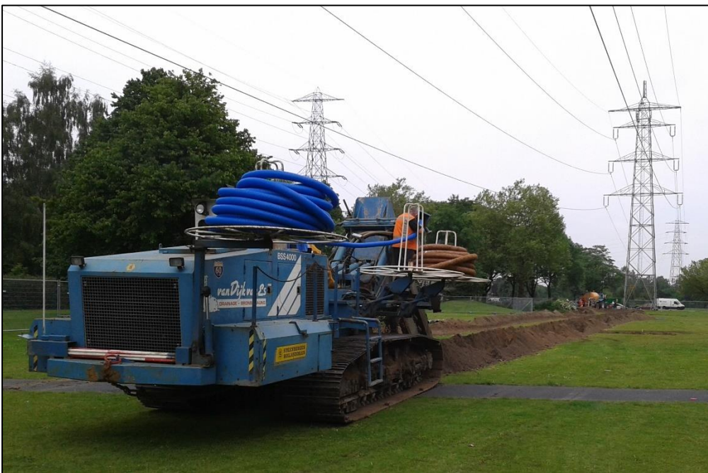
Figuur 7: Aanleg drainage met drainmachine
