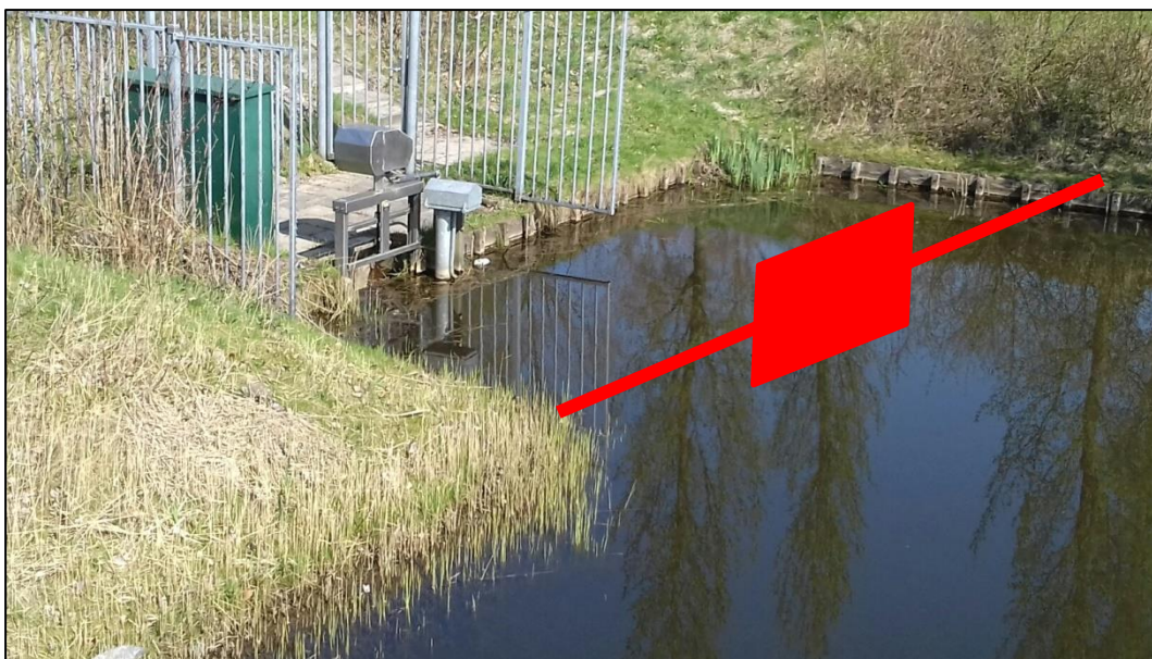
Foto 3 locatie nieuwe constructie met stuw
