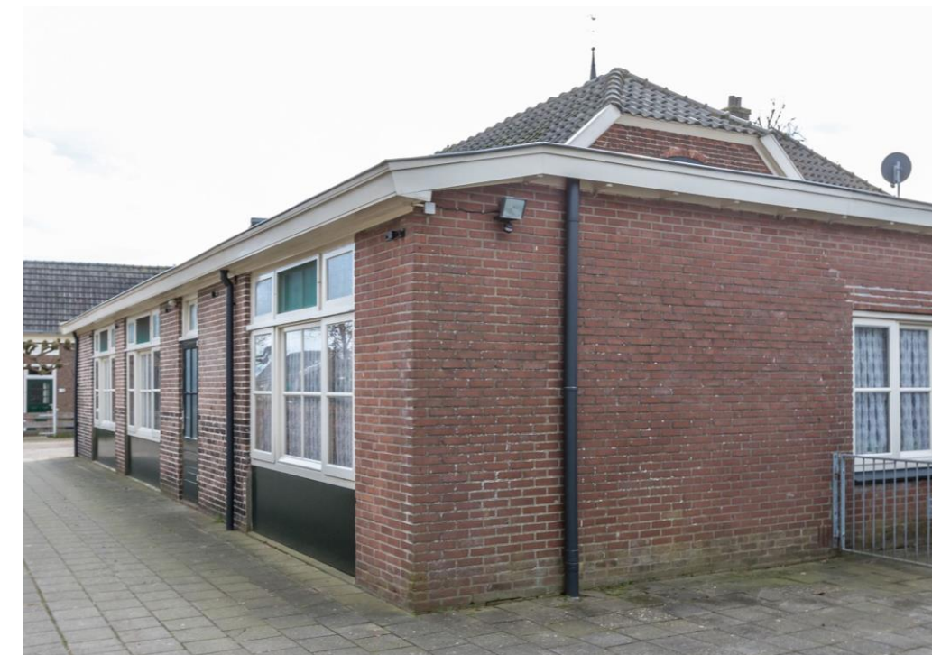
Figuur 12: De nieuwbouw is koud tegen het oude metselwerk aangezet. Het zaalgedeelte is verlengd vanaf het achterste schoolraam, het verschil in steensoort is duidelijk te herkennen.
