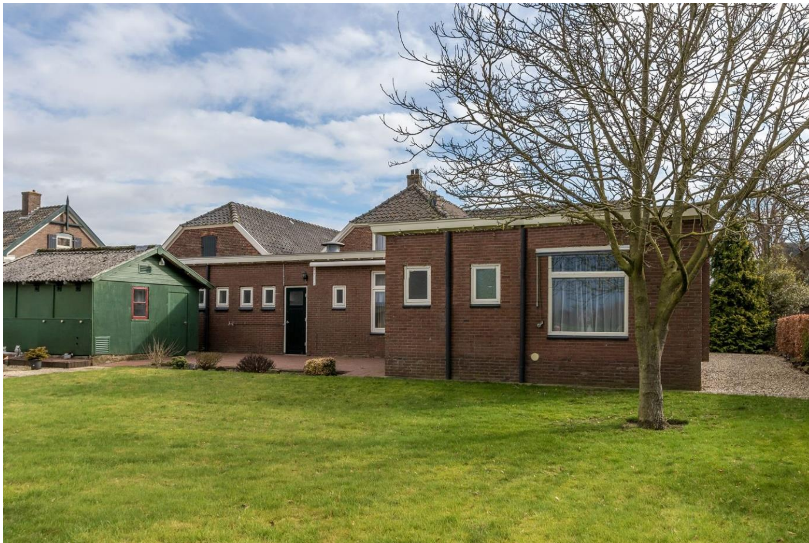
Huidige situatie achtergevel
