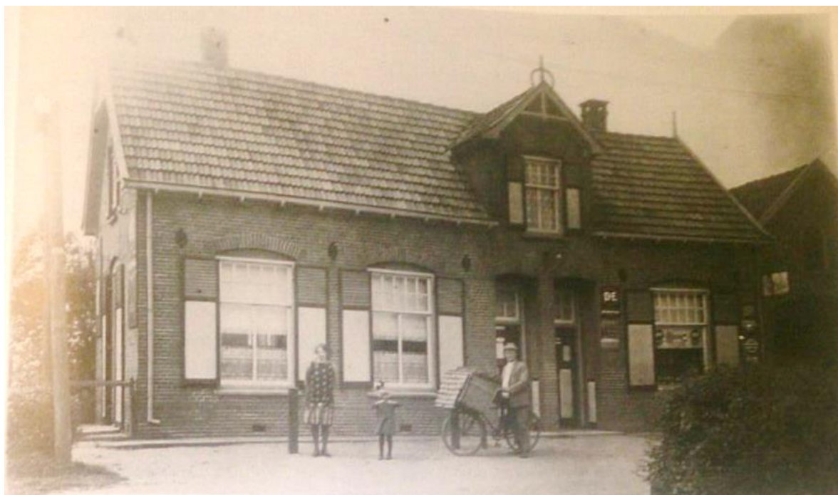
Figuur 3: Historische foto omstreeks 1930, met links het (huiskamer-)café, rechts de kruideniers winkel en uiterst rechts nog juist zichtbaar de landbouw schuur met zijn schuurdeuren en luik voor hooiopslag.
