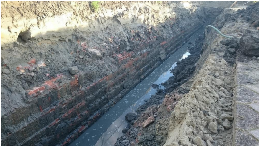
Figuur 13 Een deel van de funderingsmuur van de Ketelmakerij in de proefsleuf.
