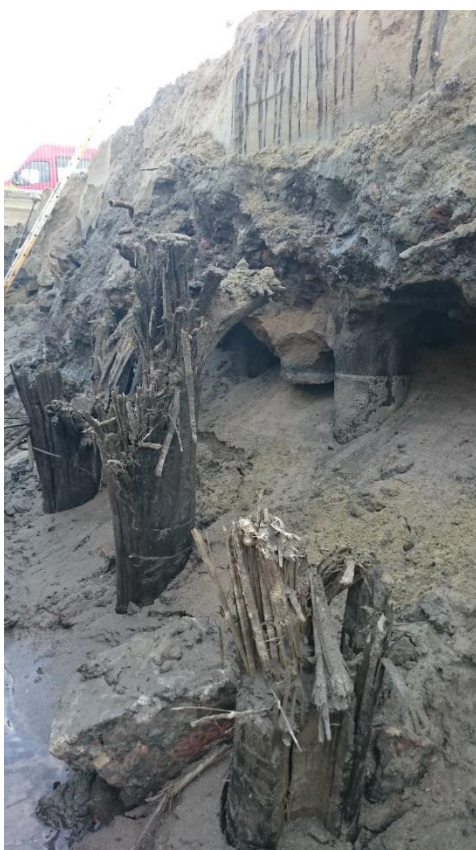
Figuur 14 Een deel van de houten palen in een dicht grid.
