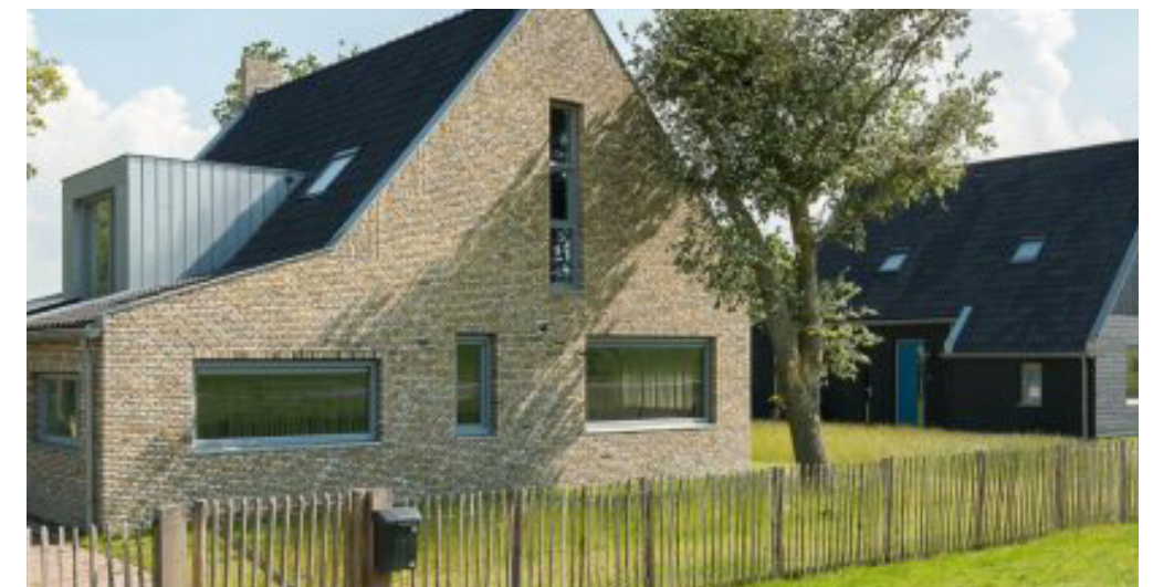
De gekozen bouwstijl refereert naar de landelijk Walcherse woningen in een eigentijdse vertaling
