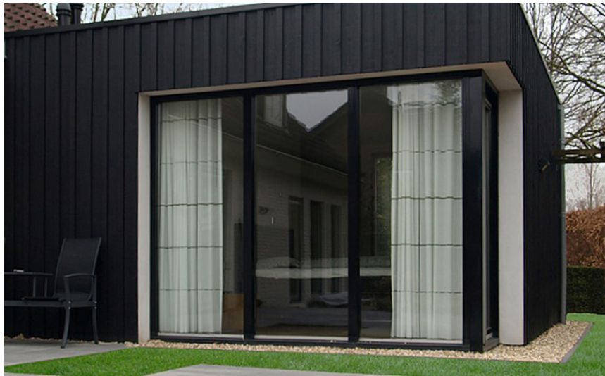
De uitbouw is voorzien van grote gevelopeningen
