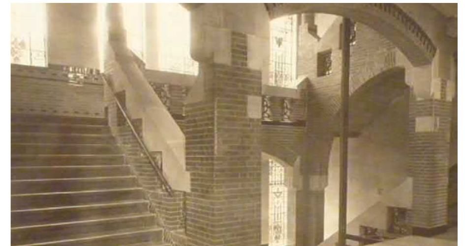
Originele trappenhuis, gezien vanaf de 1 e verdieping (1911) | SteenhuisMeurs 2016, p 19
