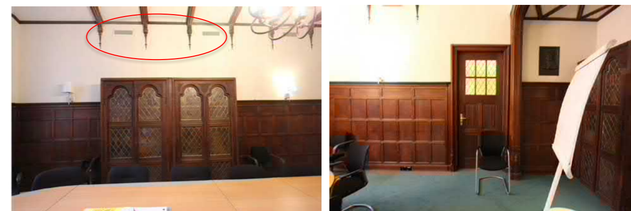
4.3 Noordelijke wand van de Gotische zaal met vaste kast en roosters luchtbehandeling (foto: MEI architecten, 1.20.01)
