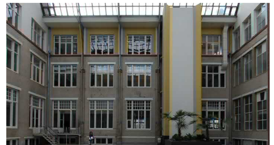
Schacht van de goederenlift westgevel binnengebied uit de jaren '70
