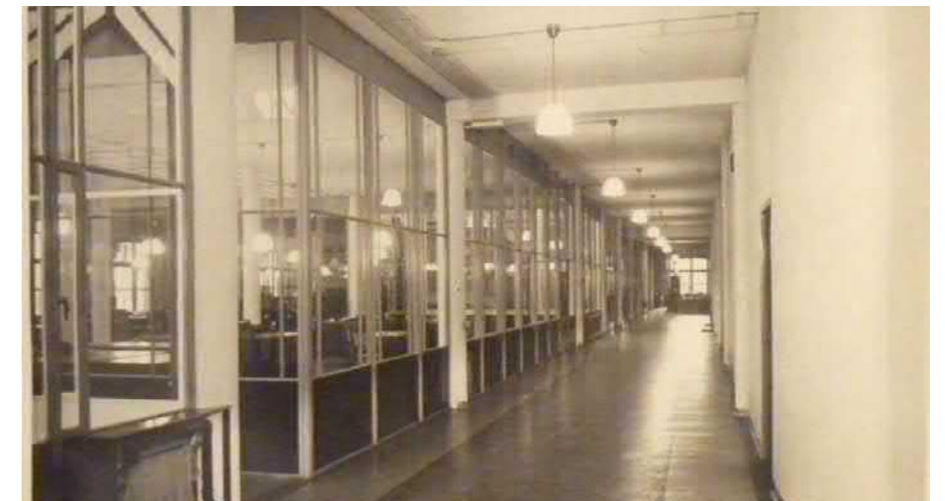
Centrale binnencorridor op de 2 e verdieping (ca. 1950) | SteenhuisMeurs 2016, p 24
