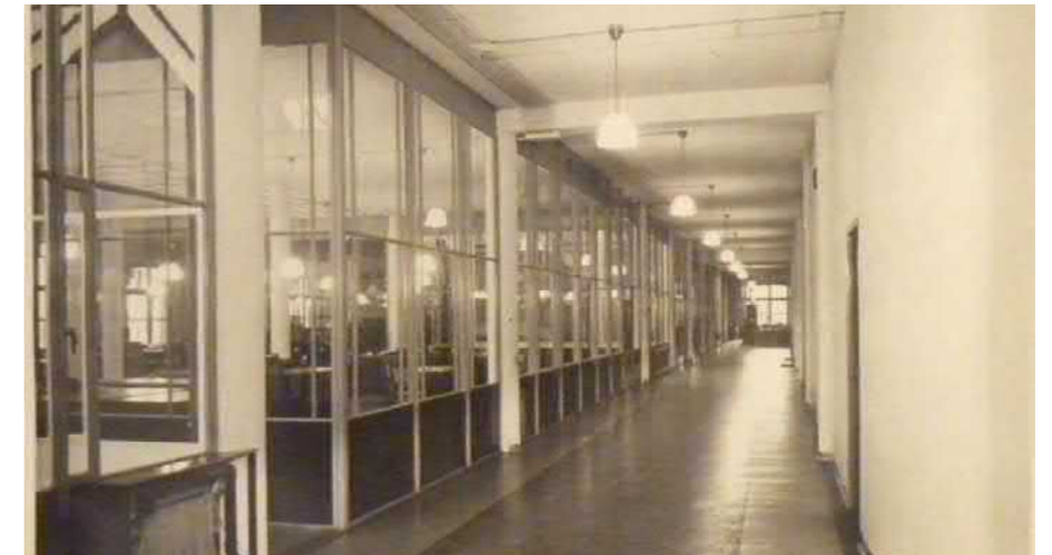
Stalen kantoorwanden op de 2 e verdieping (ca. 1950) | SteenhuisMeurs 2016, p 24
