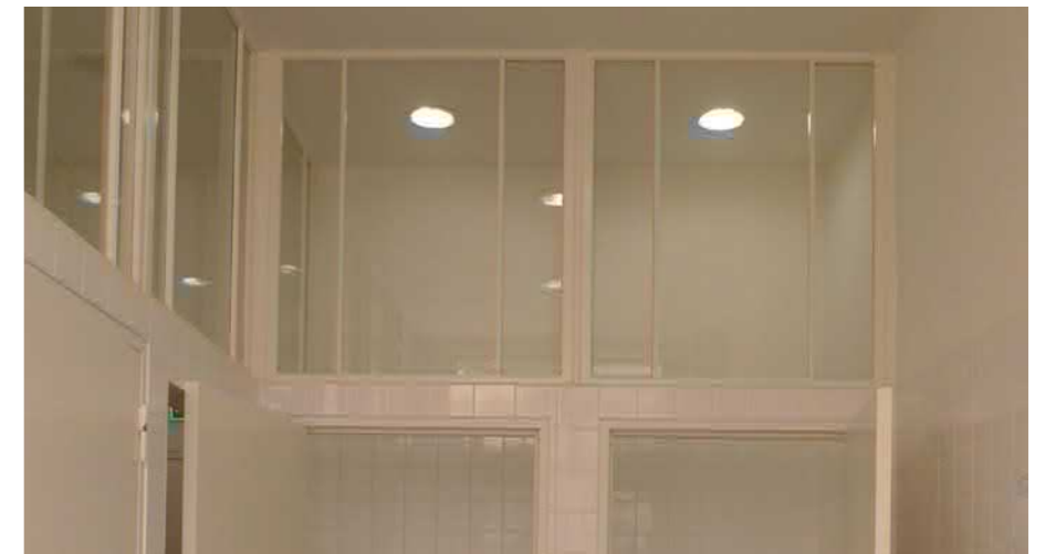
Roedeindeling van de bovenlichten in een toiletruimte op de 2 e verdieping (2016)
