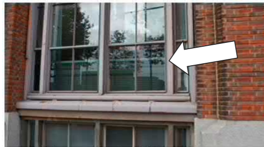
Houten kozijn frame met metalen dorpel (2016)
