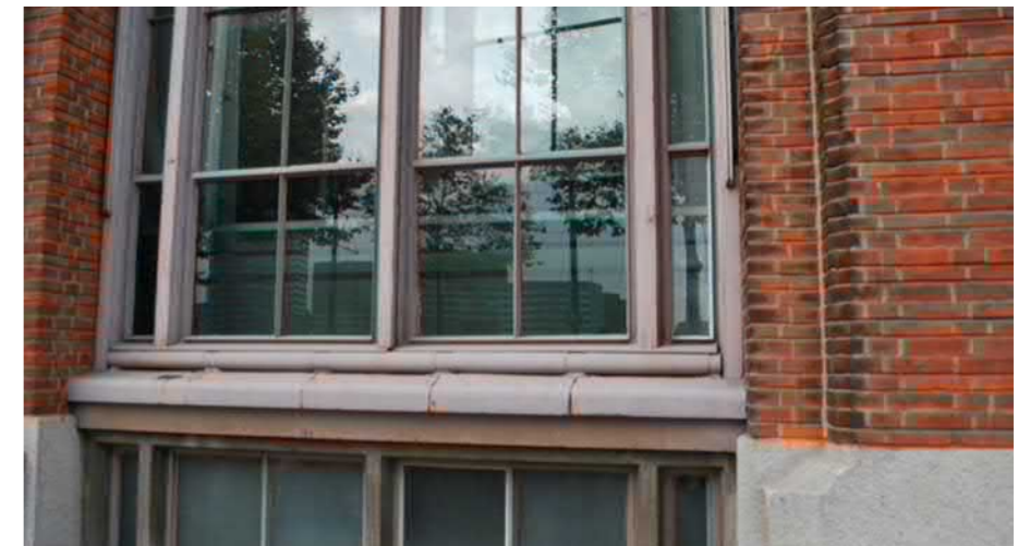
Houten kozijn frame met metalen dorpel (2016)
