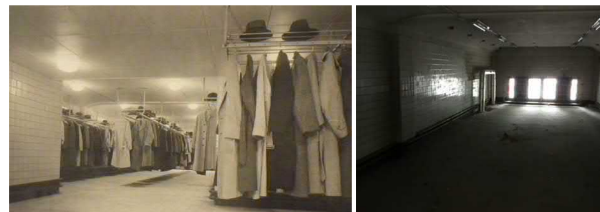
14.9 en 14.10 - Herengarderobe 1950 als referentiebeeld voor damesgarderobe op begane grond (uit: SteenhuisMeurs, p 24). Mogelijk is deze foto zelf in de huidige ruimte 0.137 genomen. (foto: Erfgoedzorg, april 2017)
