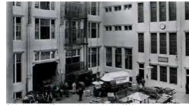
Originele goederenlift westgevel binnengebied uit 1911
