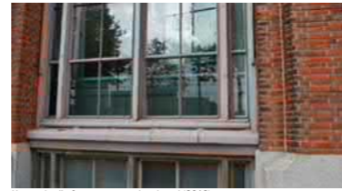
Houten kozijn frame met metalen dorpel (2016)
