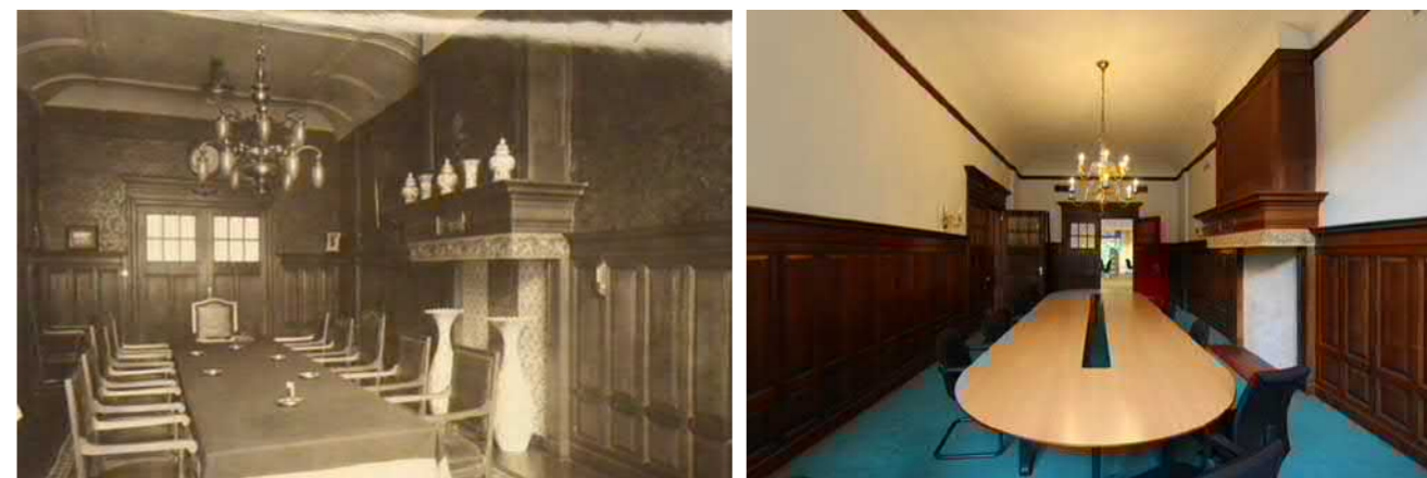
5.4 - Interieur Tudorzaal in ca 1915 met rechts de schouw (uit: SteenhuisMeurs 2016, p 19)
