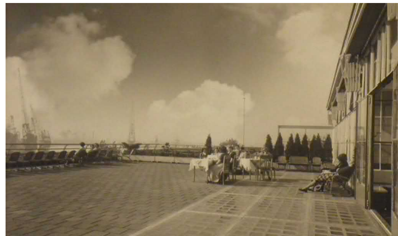
7.3 – Zicht vanaf het dakterras van de personeelkantine, circa 1950 (uit: SteenhuisMeurs 2016, p 6)
