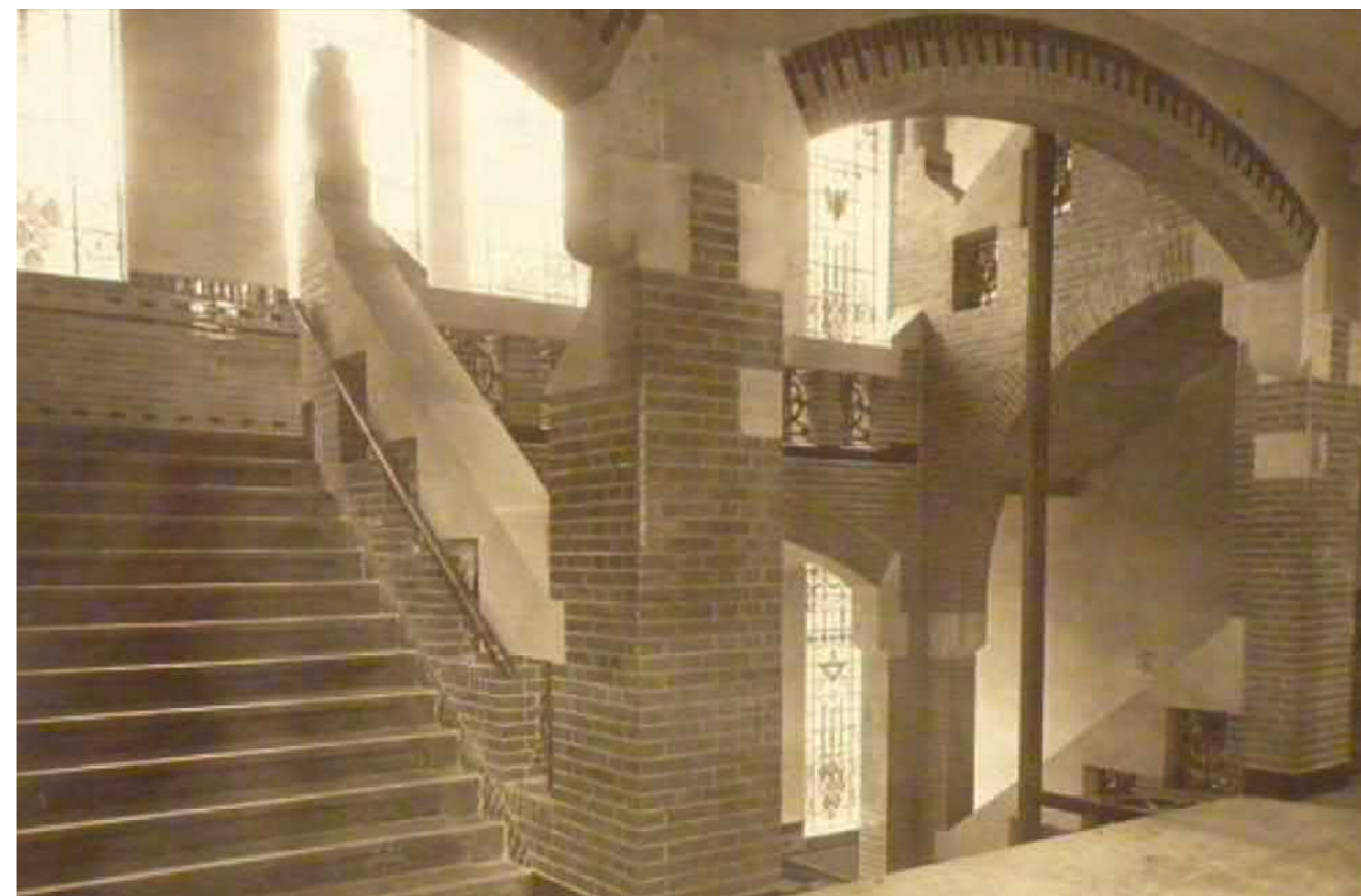
3.16 – Vooroorlogse impressie van de afwerking van het trappenhuis noord, vanaf de 1 e verdiepingvloer genomen, mogelijk ten tijde van de aanleg van de lift uit de eerste bouwperiode. Meerkleurig gebruik van geglazuurde baksteen, divers natuursteen en mogelijk smeedijzeren traphekken en bronzen leuning (nog in situ). Op de voorste pilasters twee natuursteenblokken voor bevestiging van de lifthekken, conform detail in afbeelding 3.14. Op het bordes is de gevelwand van het atrium te zien, de ramen met vermoedelijk gebrandschilderd glas (uit: MEI historische foto's nr 16)
