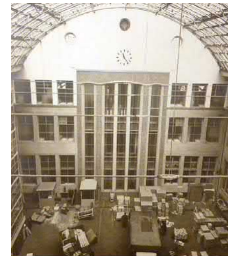
Atrium in werking (ca. 1950) | SteenhuisMeurs 2016, p 21
