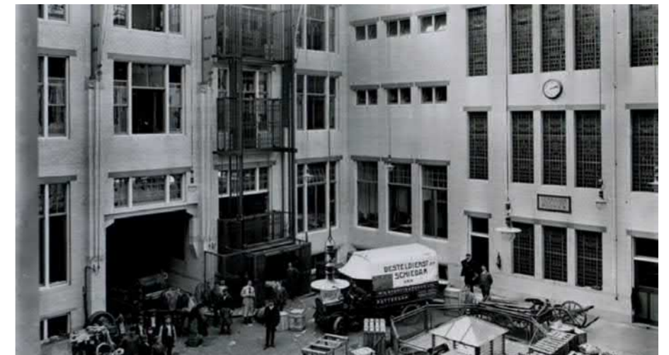
Originele goederenlift westgevel binnengebied uit 1911
