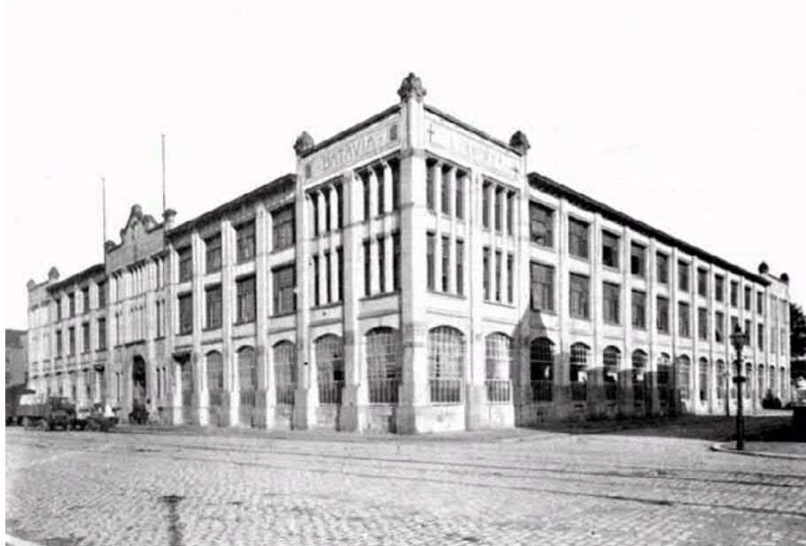
Het oude Stokvisgebouw
