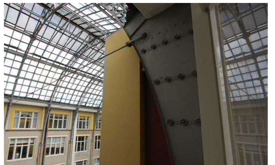
STALEN KAPSPANTEN EN ATRIUMDAK
