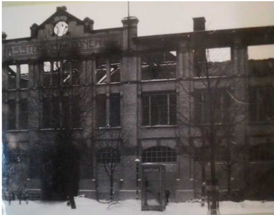
Schade aan het gebouw
