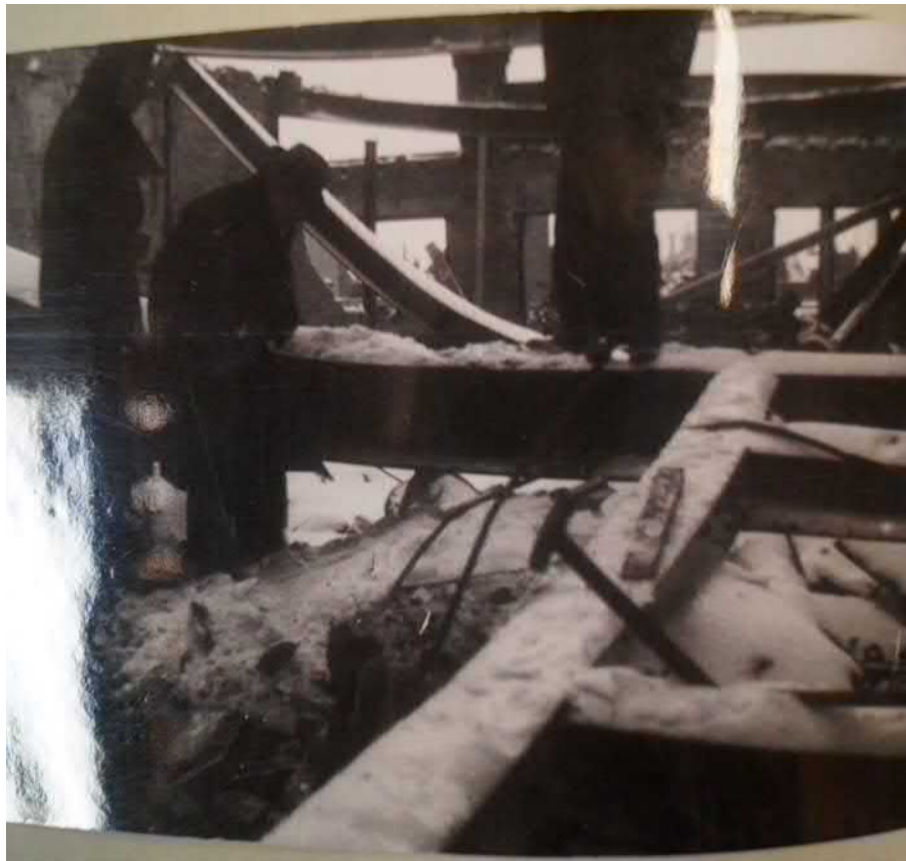
Schade aan het gebouw
