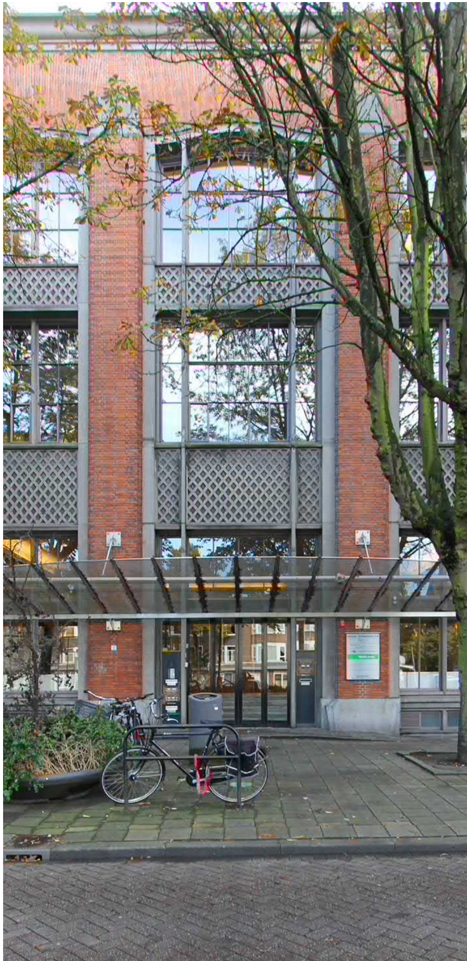
Gevelopeningen | Mei Architects and Planners
