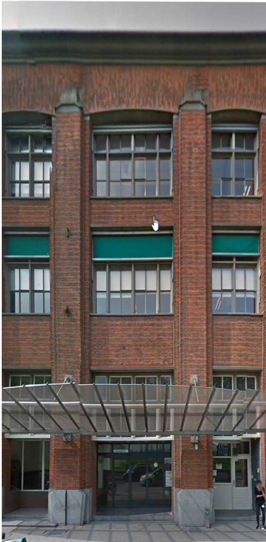
Gevelopeningen | Mei Architects and Planners
