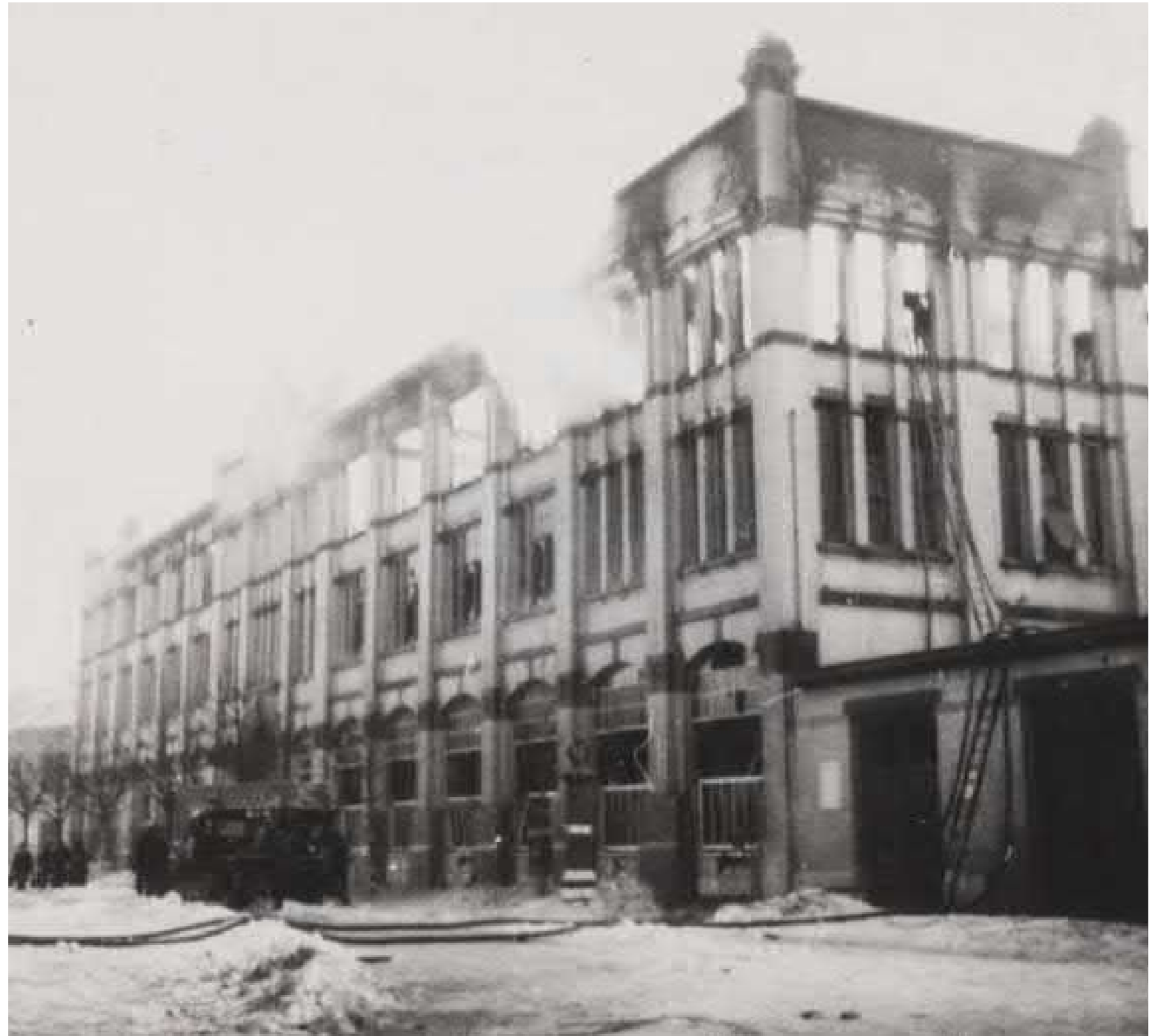
Schade aan het gebouw
