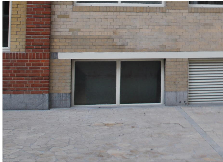
Kozijn type 30: (begane grond, atrium noordgevel) - origineel stalen kozijnen en ramen; - voorzien van enkel glas; - veelal voorzien van origineel hang- en sluitwerk; - deels voorzien van ventilatieroosters.
