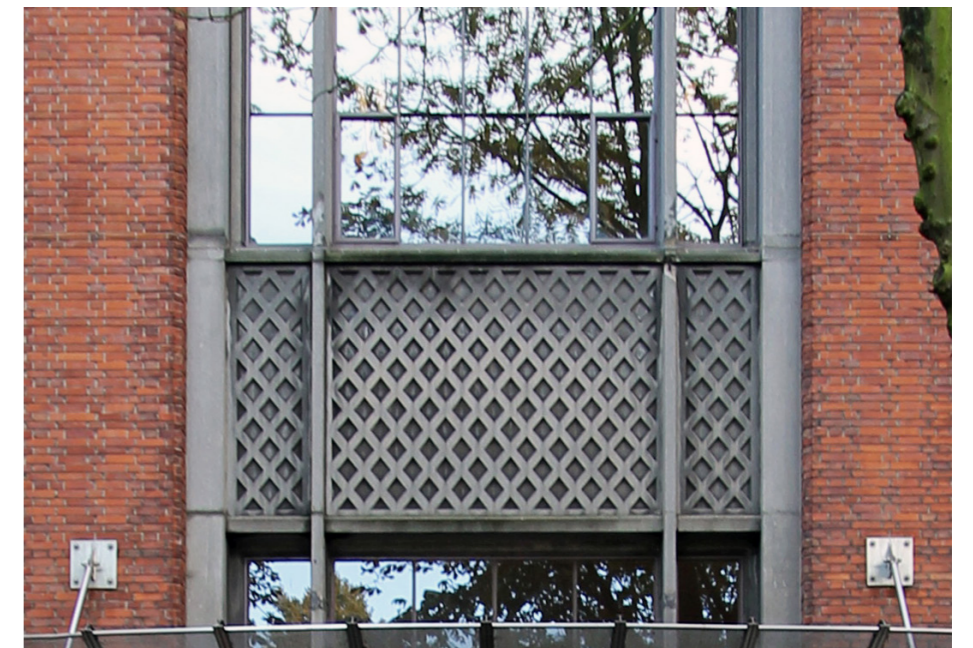
In de noordgevel is boven de entree en de flankerende traveeën tussen de ramen ruitvormig sierbeton aangebracht.
