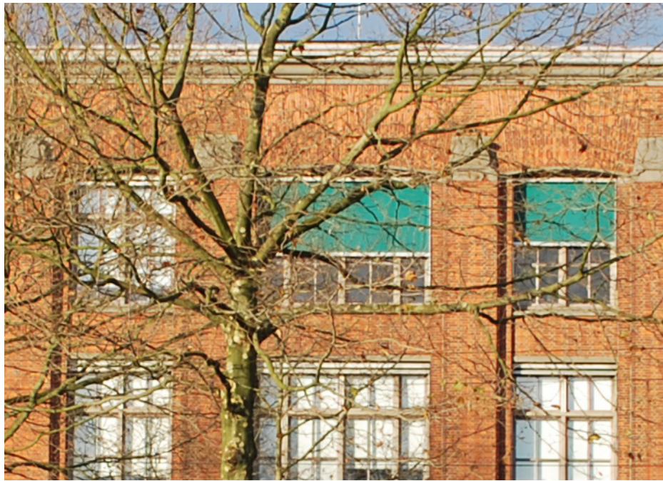
Kozijn type 21-22: (2e verdieping, entree zuidgevel) - origineel betonkader; - origineel stalen kozijnen en ramen; - voorzien van enkel glas; - te openen ramen conform oorspronkelijke indeling; - veelal voorzien van origineel hang- en sluitwerk.
