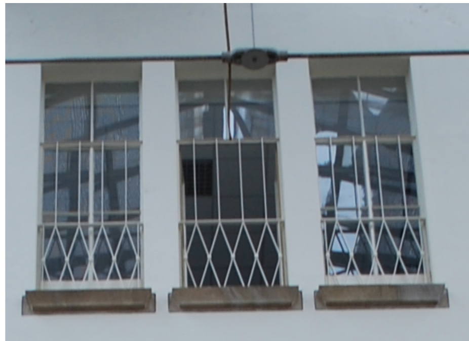
Kozijn type 41: (3e verdieping, atrium zuidgevel) - origineel stalen kozijnen en ramen; - voorzien van enkel glas; - veelal voorzien van origineel hang- en sluitwerk.
