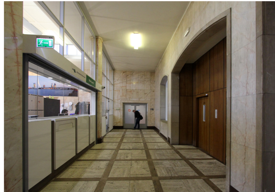
De Julianahal op de tweede verdieping met marmerlambrizing en betonnen cassetteplafond met een vensterstrook geheel rondom.
