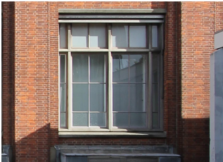
Kozijn type 2e: (2x begane grond, westgevel) - origineel betonkader; - origineel stalen kozijnen en ramen; - voorzien van enkel glas met achterzetramen; - te openen ramen conform oorspronkelijke indeling; - veelal voorzien van origineel hang- en sluitwerk; - figuurglas in onderste strook.
