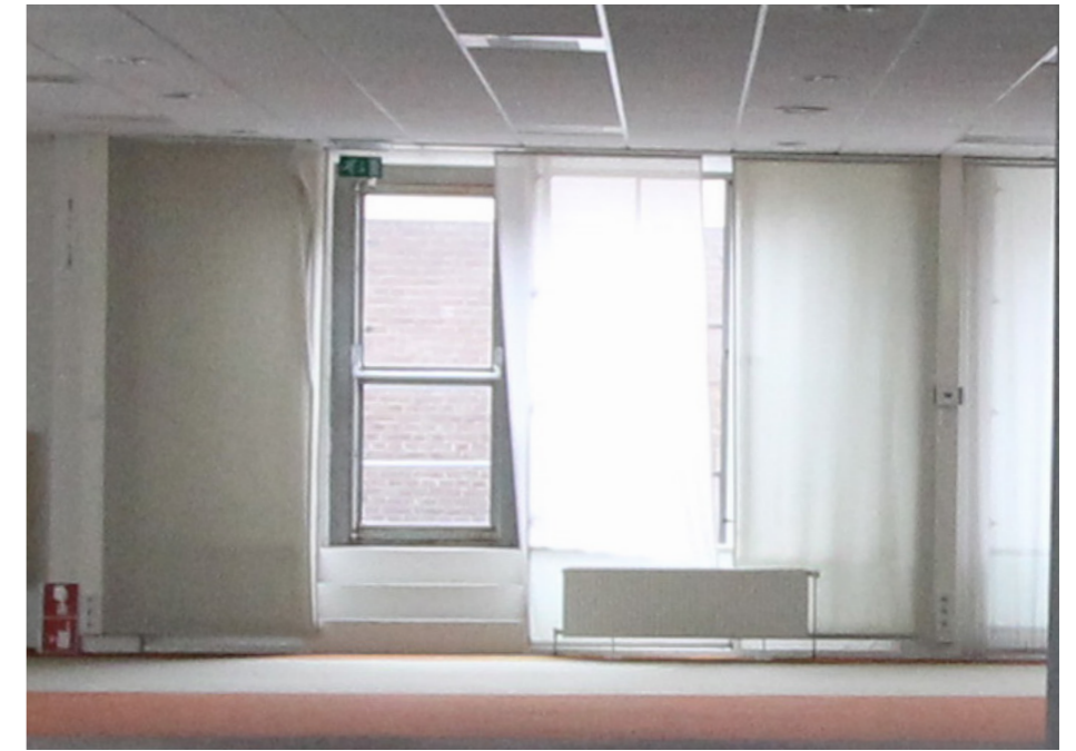
Kozijn type 2b: (1x begane grond, westgevel) - origineel betonkader; - origineel stalen kozijnen en ramen; - voorzien van enkel glas en deels met achterzetramen; - te openen ramen conform oorspronkelijke indeling; - veelal voorzien van origineel hang- en sluitwerk; - figuurglas in onderste strook; - voorzien van enkele dichte deur.
