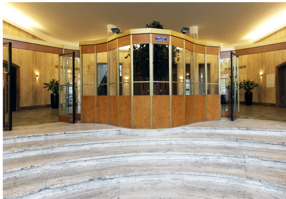
Travertijn trap achter de hoofdentree met elipsvormige portiersloge (waarvan alleen de achterwand resteert).
