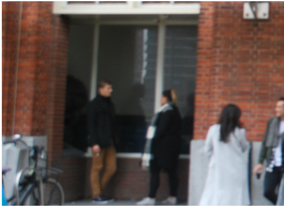
Kozijn type 5: (1x begane grond, entree noordgevel) - origineel kozijn vervangen en deels terug geplaatst in de gevel; - waarschijnlijk houten kozijnen; - voorzien van enkel glas.
