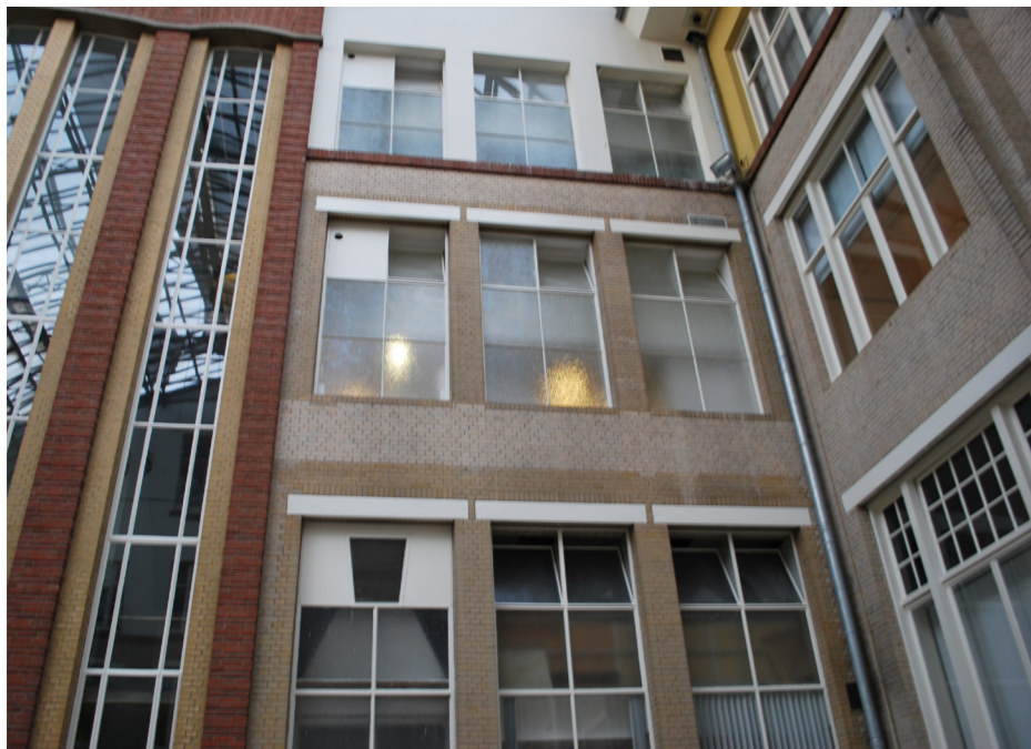
Kozijn type 25-36-38: (begane grond, 1e en 2e verdieping, atrium noordgevel) - origineel stalen kozijnen en ramen; - voorzien van enkel glas; - deels voorzien van gesloten delen met ventilatie rooster; - veelal voorzien van origineel hang- en sluitwerk.
