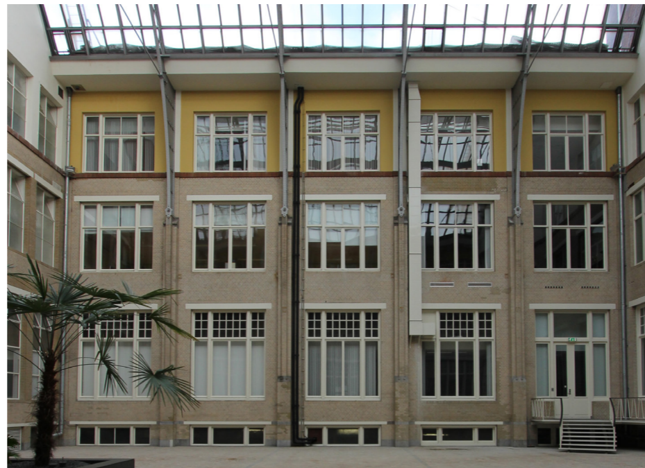
Kozijn type 26-31-37-39: (begane grond, 1e en 2e verdieping, atrium) - origineel houten kozijnen en ramen; - voorzien van enkel glas; - te openen ramen conform oorspronkelijke indeling; - te openen delen zijn in huidige staat veelal niet meer te openen door schilderwerk.
