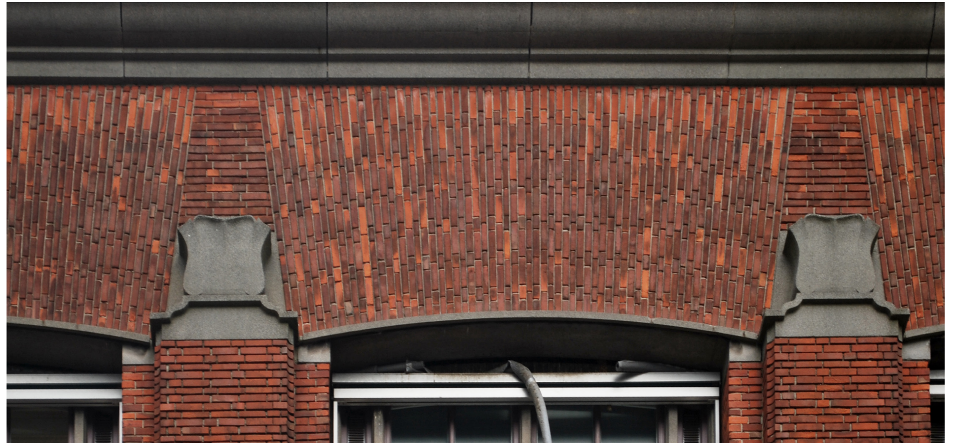
De metselwerk pilasters zijn bovenaan voorzien van een decoratieve bekroning. De gevels worden afgesloten met een geprofileerde betonnen daklijst.
