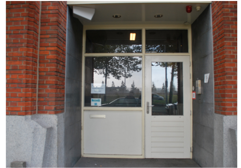
Kozijn type 7: (begane grond, entree zuidgevel) - origineel kozijn vervangen en deels terug geplaatst in de gevel; - houten kozijnen; - voorzien van enkel glas.
