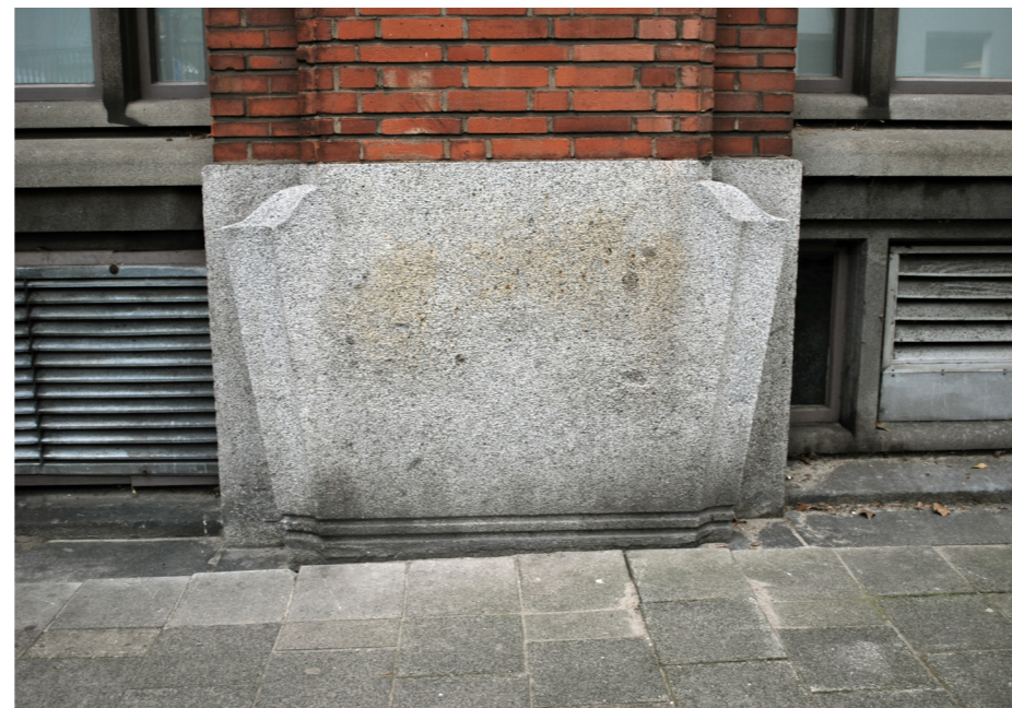
De sierbetonnen basementen van de metselwerk pilasters in de buitengevels werden uitgeoord uit de in 1909 geplaatste pilasters.
