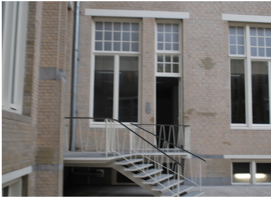
Kozijn type 28-29: (1x begane grond, atrium) - origineel houten kozijnen en ramen; - voorzien van enkel glas; - te openen ramen conform oorspronkelijke indeling; - te openen delen zijn in huidige staat veelal niet meer te openen door schilderwerk.
