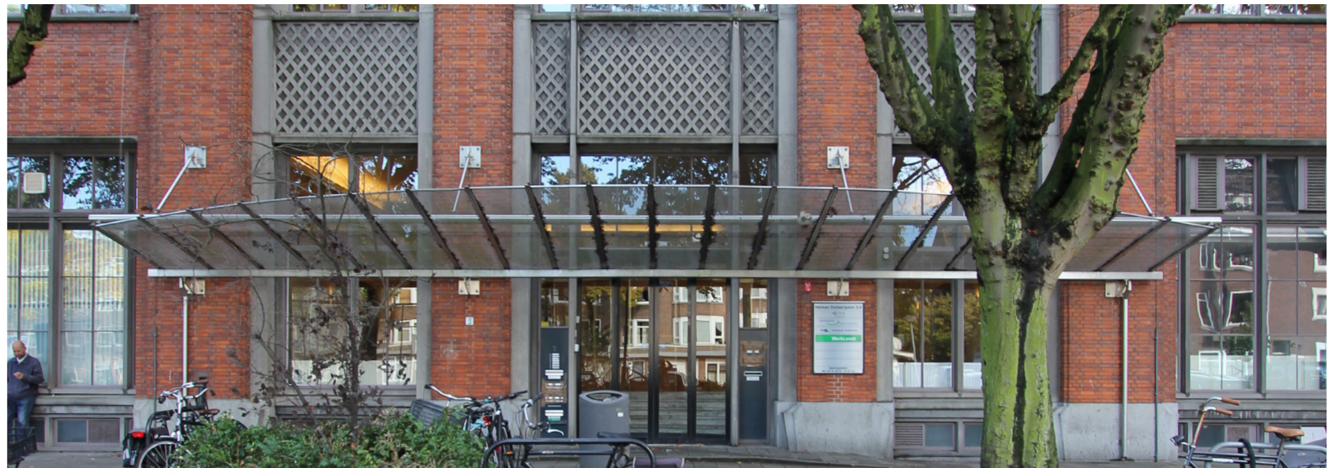
Kozijn type 3: (2x begane grond, entree noordgevel) - origineel betonkader; - origineel stalen kozijnen en ramen; - voorzien van enkel glas; - veelal voorzien van origineel hang- en sluitwerk.
