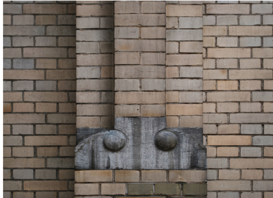
Sierbetonnen ornamenten zijn verwerkt in de metselwerk pilasters die de atriumkap ondersteunen.
