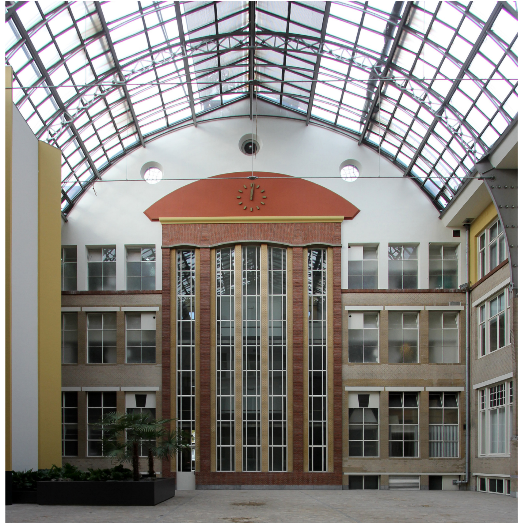
Noordgevel atrium met lichtgele baksteen en gestuct vanaf de tweede verdieping.
