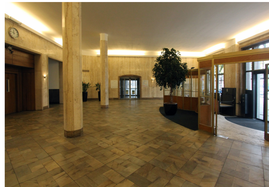
Hal hoofdentree met een natuursteen vloer en traverijnen lambrizing tegen de wanden en pilaren.
