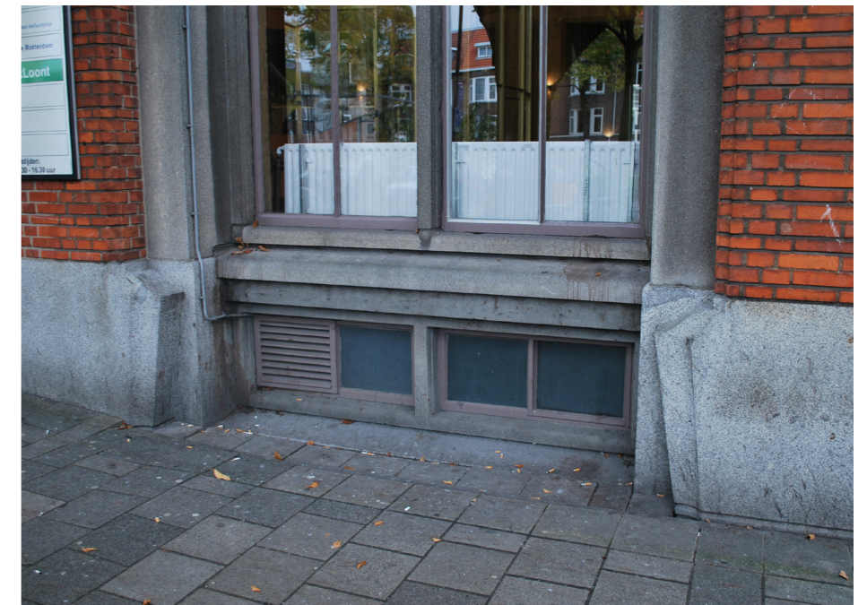
Kozijn type 11: (1x begane grond, westgevel) - origineel betonkader; - origineel stalen kozijnen en ramen; - voorzien van enkel glas; - te openen ramen conform oorspronkelijke indeling; - veelal voorzien van origineel hang- en sluitwerk; - deels voorzien van figuurglas, dicht paneel en ventilatierooster.
