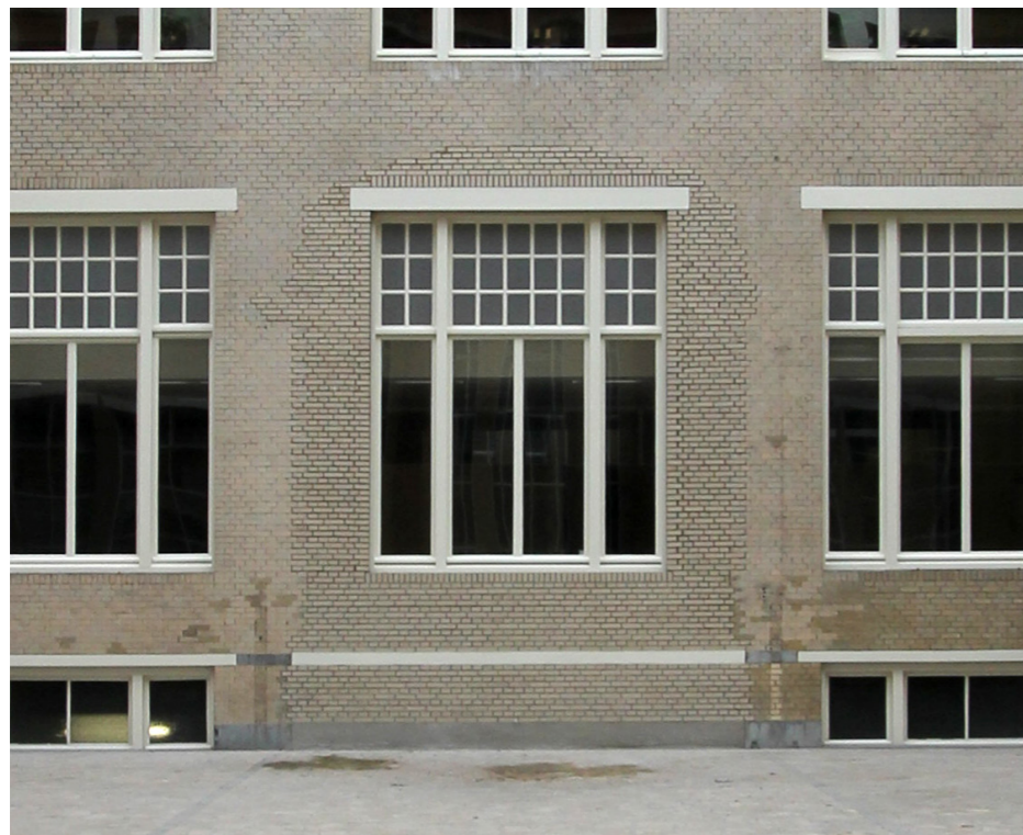
Plek oude doorgang te zien aan afwijkende kleur voegwerk.
