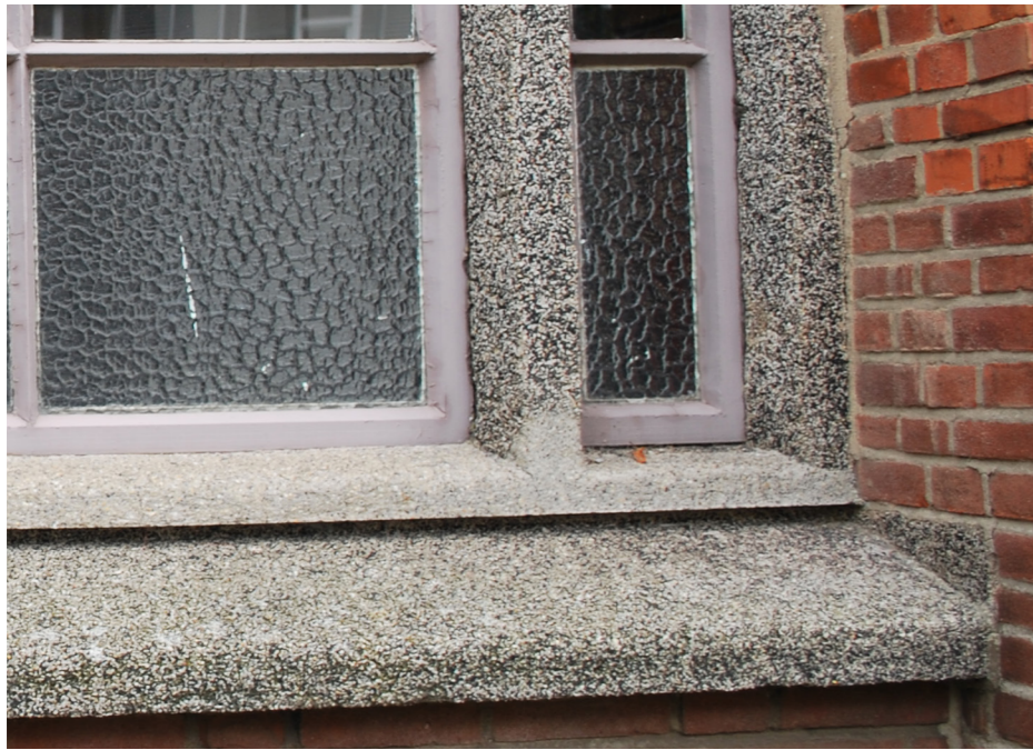
Kozijn type 2b: (2x begane grond, westgevel) - kader van afwijkend beton, later toegevoegd; - stalen kozijnen en ramen zoals overigen; - voorzien van enkel glas; - te openen ramen conform oorspronkelijke indeling; - veelal voorzien van origineel hang- en sluitwerk; - figuurglas in onderste strook;
