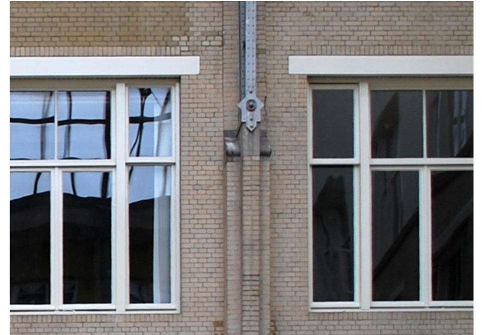
Ornamenten daar waar de boogvormige ijzeren vakwerkspanten worden ondersteund door de metselwerk pilasters.
