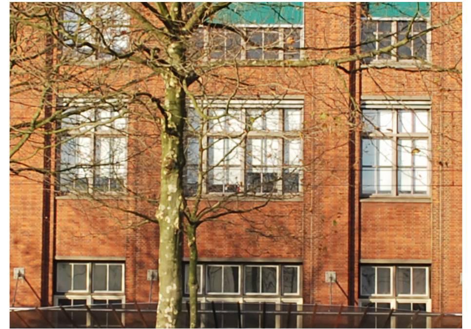
Kozijn type 15-16: (1e verdieping, entree zuidgevel)
