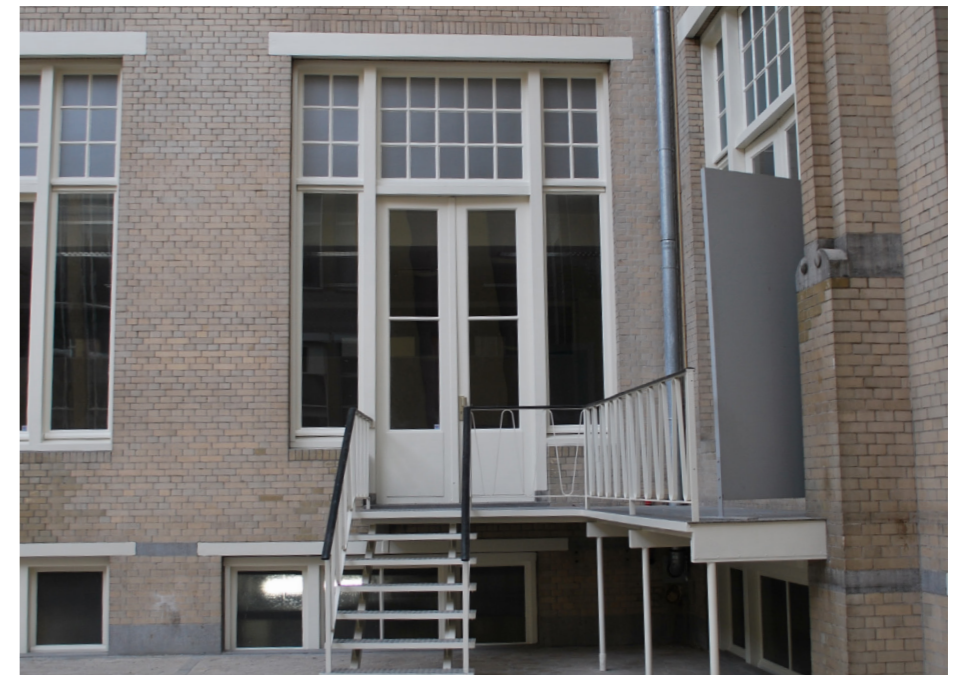
Kozijn type 27: (3x begane grond, atrium) - origineel houten kozijnen en ramen; - voorzien van enkel glas; - te openen ramen conform oorspronkelijke indeling; - te openen delen zijn in huidige staat veelal niet meer te openen door schilderwerk.
