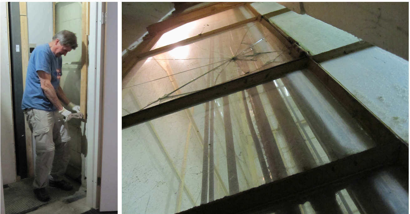
9.9 - Vrijleggen binnenzijde schacht uit 1950 door Avi Lev, voorruimte lift op begane grond (foto: Erfgoedzorg)
