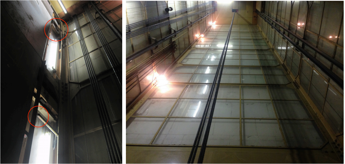
9.7 - Binnenzijde van de schacht, naast liftdeuren, met afgezaagde (raam)roeden (foto: Erfgoedzorg)
