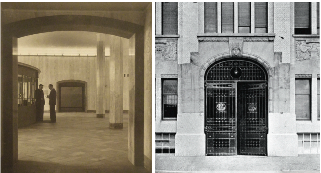
1.11 – Entreehal Heiman Dullaertplein, vanuit de westelijke zijhal, met natuursteenbekleding van wanden en kolommen en met links de portiersloge in circa 1950 (uit: SteenhuisMeurs 2016, p 29)
