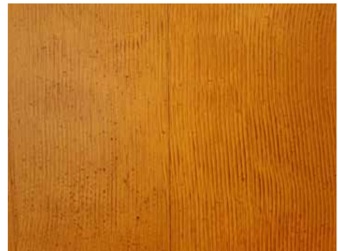
afb 18 - Bij de zuidelijke liften is de scheiding aangegeven met een potloodlijntje en lopen de nerftekeningen enigszins in elkaar over
