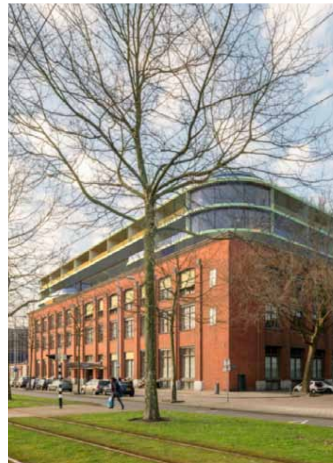
afb 1 - WEST507 Transformatie van het Oceanhuis aan de Westzeedijk in Rotterdam, impressie van het ontwerp (bron: website MEI architects and planners < http://mei-arch.eu/nieuwsbrief-april-2017/ > d.d. 14 april 2017)
