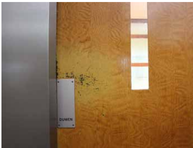
afb 32 - Slijtschade in houtimitatie 1 op greephoogte. In de lacunes is het voorliggende afwerkingsstadium te zien.
