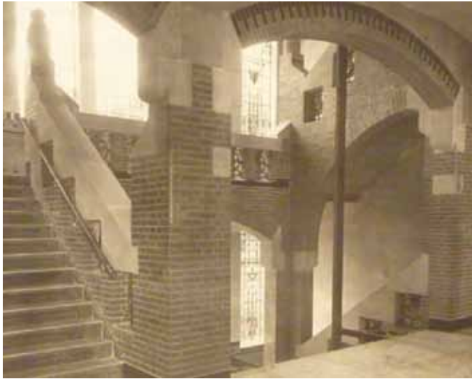
afb 9 - Interieur centraal trappenhuis circa 1915. Hier zonder valbescherming van de liftschacht, mogelijk tijdens de plaatsing genomen (bron SteenhuisMeurs 2016, p 19)
