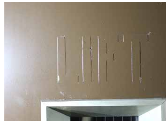
afb 30 - De plakletters LIFT op de liftdeur in de kelder (noordzijde) zijn overschilderd bij de tweede verfbeurt
