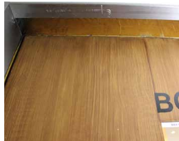
afb 23 - Binnenzijde liftdeur noordelijke liften, overschilderd met houtimitatie 2. Boven de deur is houtimitatie 1 nog te zien.
