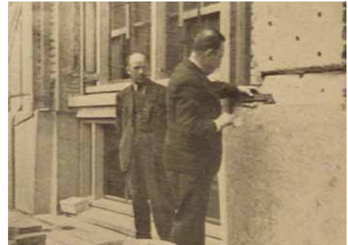
afb 2 - Fred Stokvis, een van de teruggekeerde eigenaren legde in 1947 de eerste steen voor de herbouw van het in 1942 deels verwoeste pand (bron: SteenhuisMeurs 2016, p 23)
