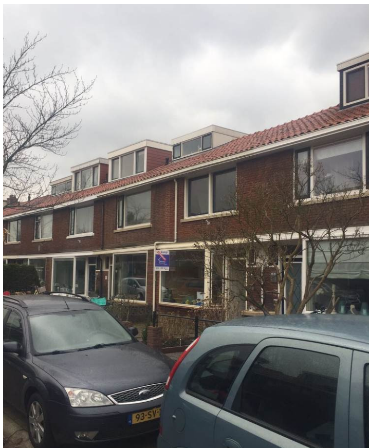
Dakkapellen in de straat
