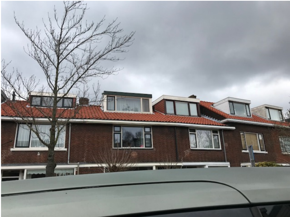
Dakkapellen in de straat
