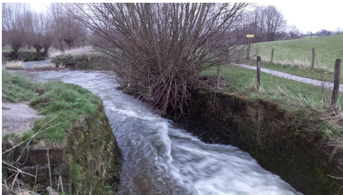
Figuur 4 De oeverbeschoeiingen bestaande uit stapelstenen t.h.v. de watermolen.
