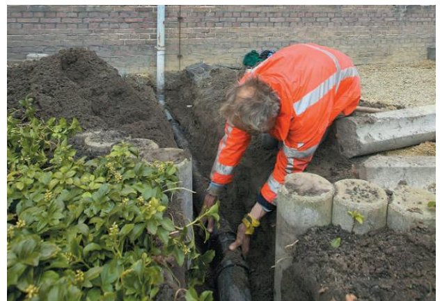
Figuur 2-1: Afkoppelen van een regenpijp
