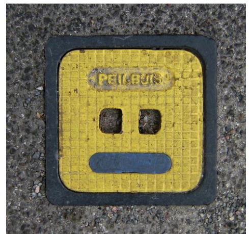
Figuur 6-3 Peilbuis voor grondwatermetingen
