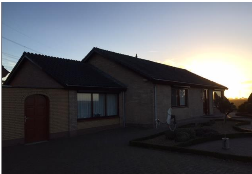
Figuur 1.4: foto voormalige agrarische bedrijfswoning
