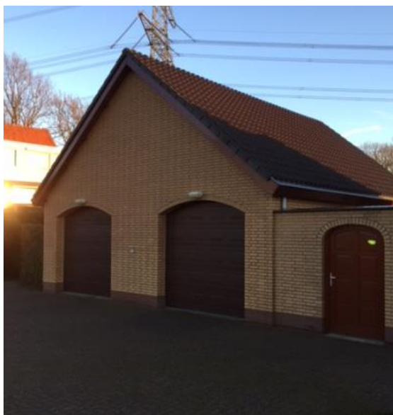
Figuur 1.5: foto voormalige agrarische bedrijfsbebouwing
