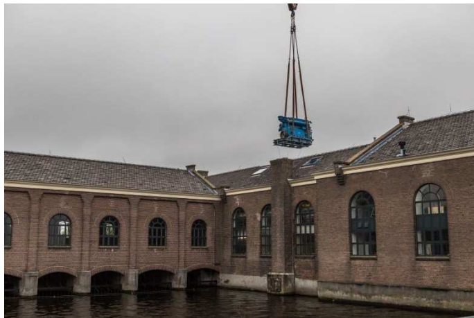
Plaatsing elektromotoren in boezemgemaal Spaarndam
