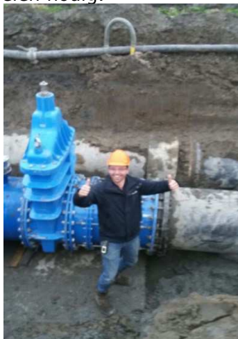
Nieuwe persleiding in de Haarlemmermeer gerealiseerd
