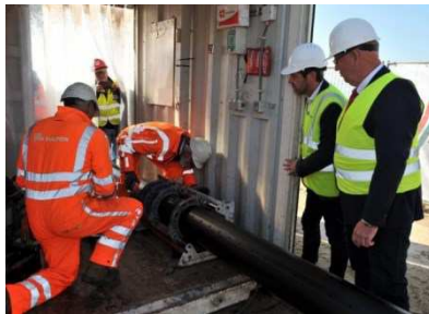
Grondwaterproblemen in Noordwijk aangepakt
