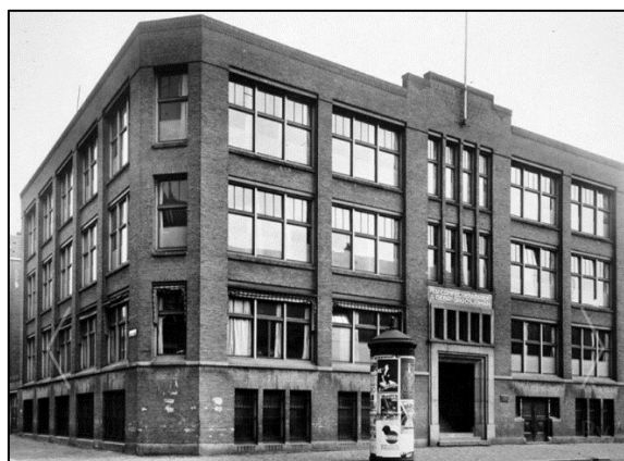
Figuur 2.1 Aangezicht van de oorspronkelijke zuidgevel
