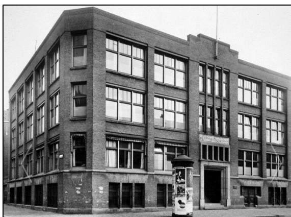
Figuur 2.1 Aangezicht van de oorspronkelijke zuidgevel
