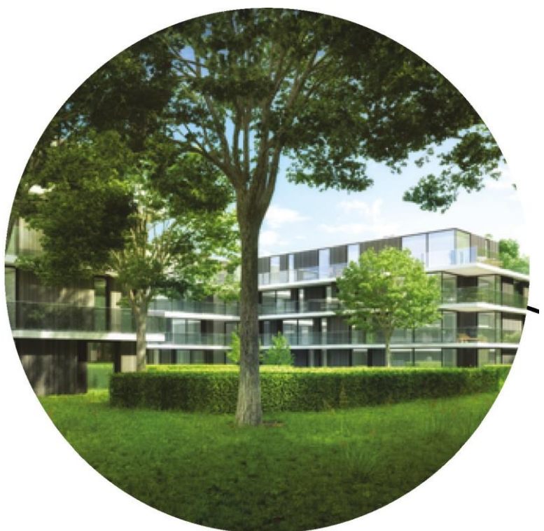
gemeentelijke referentie nieuwbouw: horizontale accentuatie en contrast met bestaand Missiehuis
