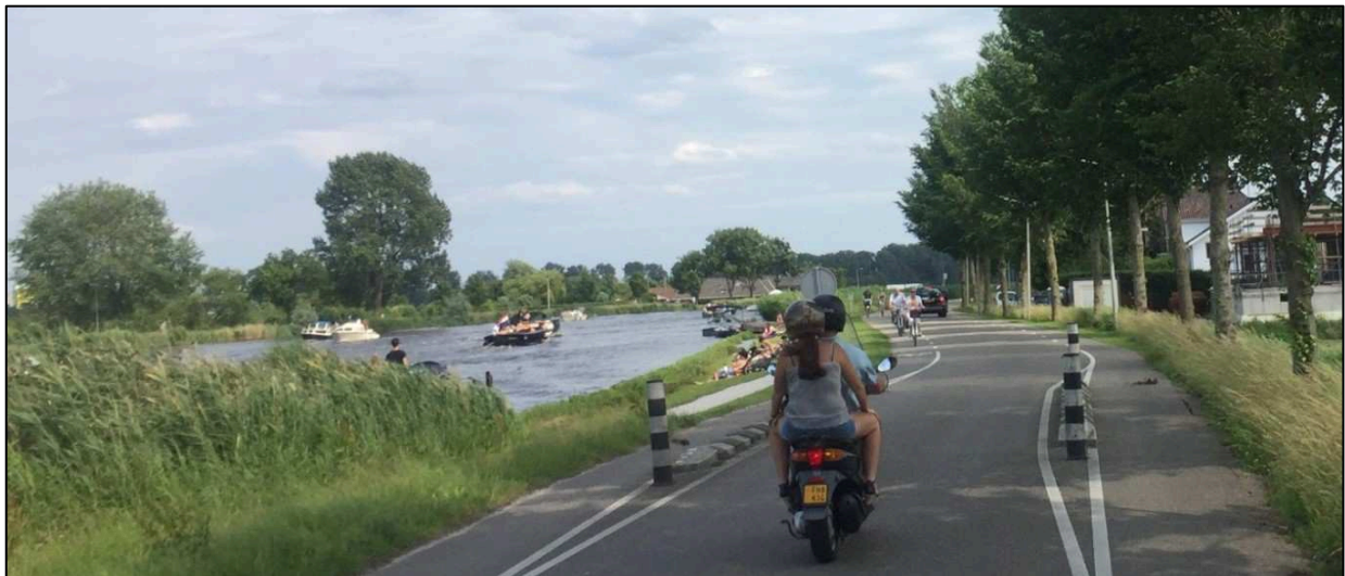
Figuur 4.1 Gebruik van de dijk
