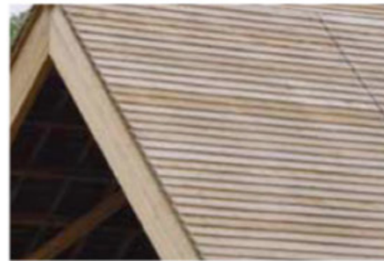
Siberisch Lariks potdeksel hoogte: 150 mm dikte: 20 mm
