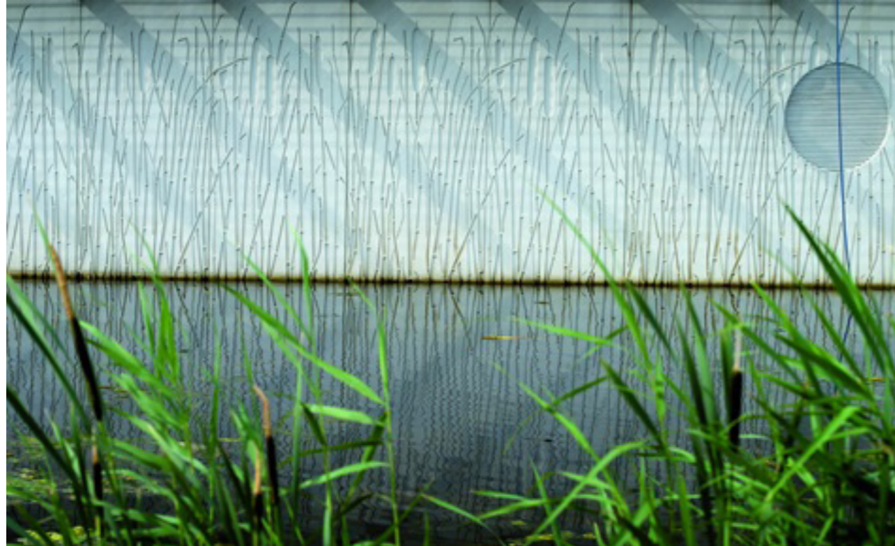
GEMEENTEHUIS LANSINGERLAND - BETON ELEMENT MET RIETSTRUCTUUR
