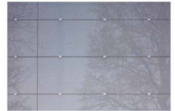
Glas vlakke stroken formaat 600 x 2400 mm 1200 mm Dikte 8 mm groen (RAL 6019 witgroen))
