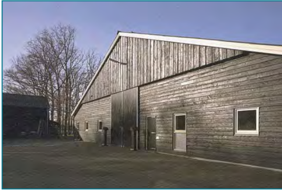
Zadeldak, topgevel met hout bekleed
