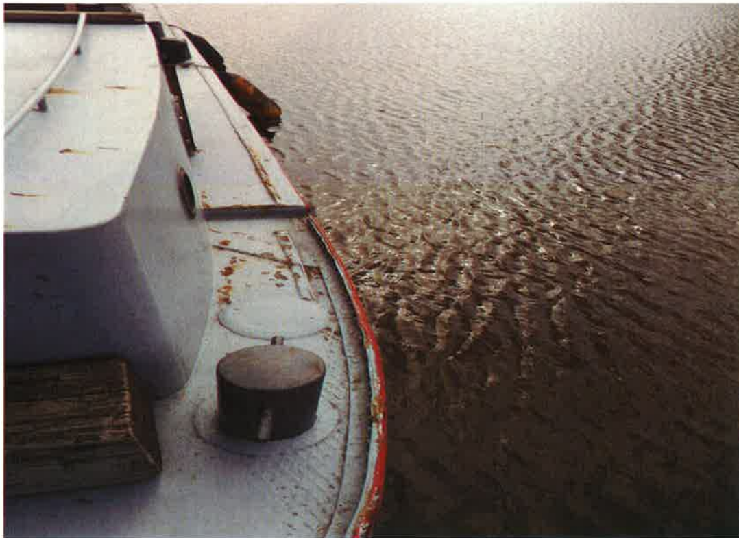
Afbeelding 6 twee opgelaste bolders (foto 483)
