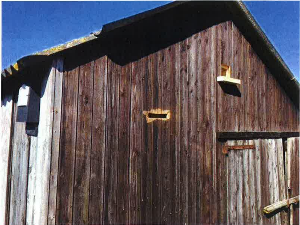
Figuur 5.10 Schuur met kerkuilkast in kopse gevel
