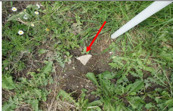
Foto nr. 12 zwerfasbest tussenruimte tussen loods 1 en loods 2 identiek aan M 3
