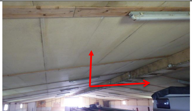
Foto nr. 7 plafond beplating loods 2, asbest M 1
