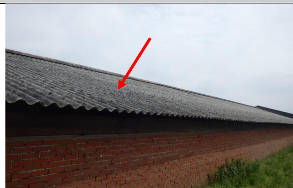
Foto nr. 1, Golfplaten van loods 1 M 3 asbest
