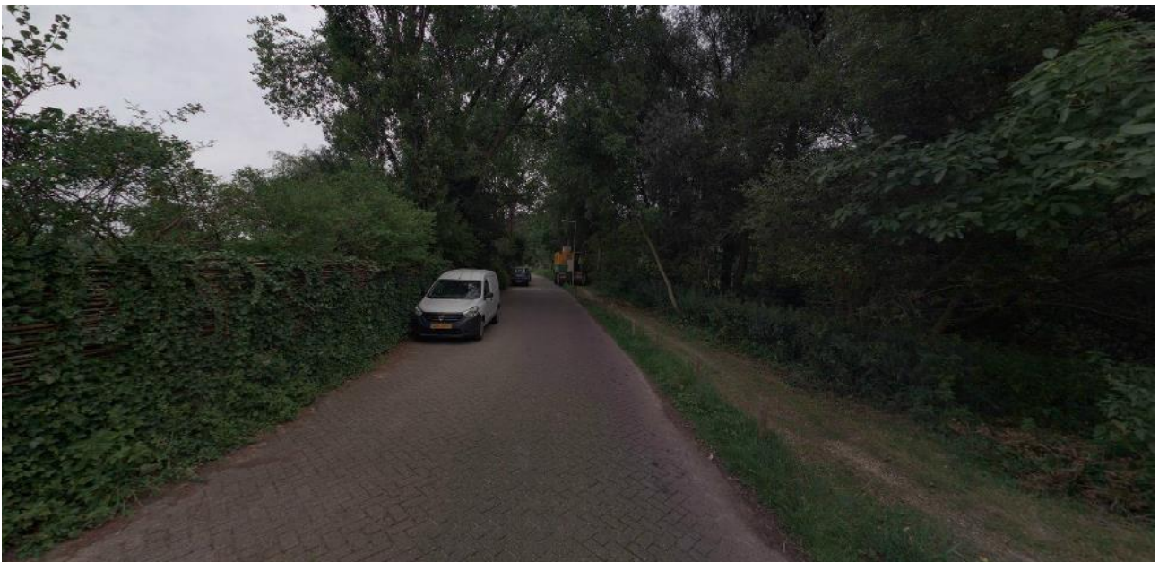
Figuur 3: Situatie ter plaatse van dijkvak A130_003
