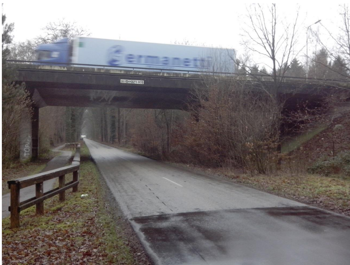
Figuur 4. Viaduct onder de A27/A58 met aan weerszijden van de weg faunapassages.
