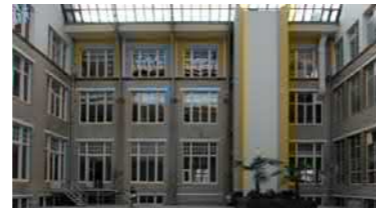
Schacht van de goederenlift westgevel binnengebied uit de jaren '70
