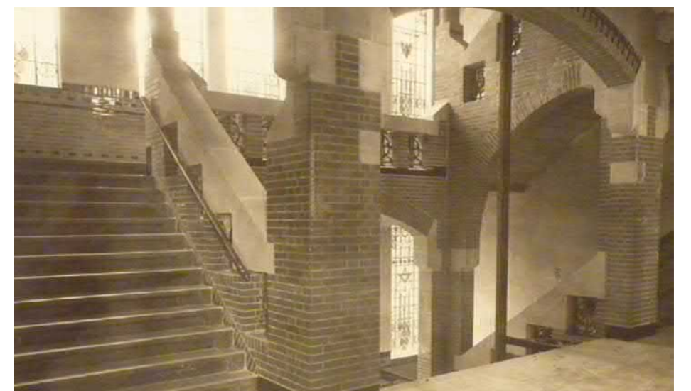
oorspronkelijk trappenhuis zonder liften
