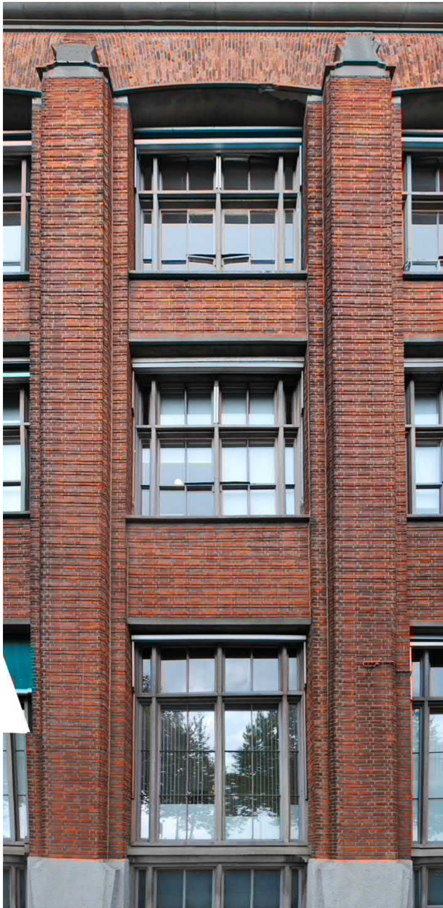
Gevelopeningen | Mei Architects and Planners
