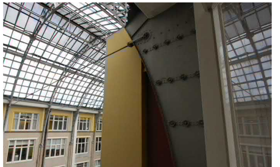
STALEN KAPSPANTEN EN ATRIUMDAK
