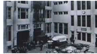
Originele goederenlift westgevel binnengebied uit 1911
