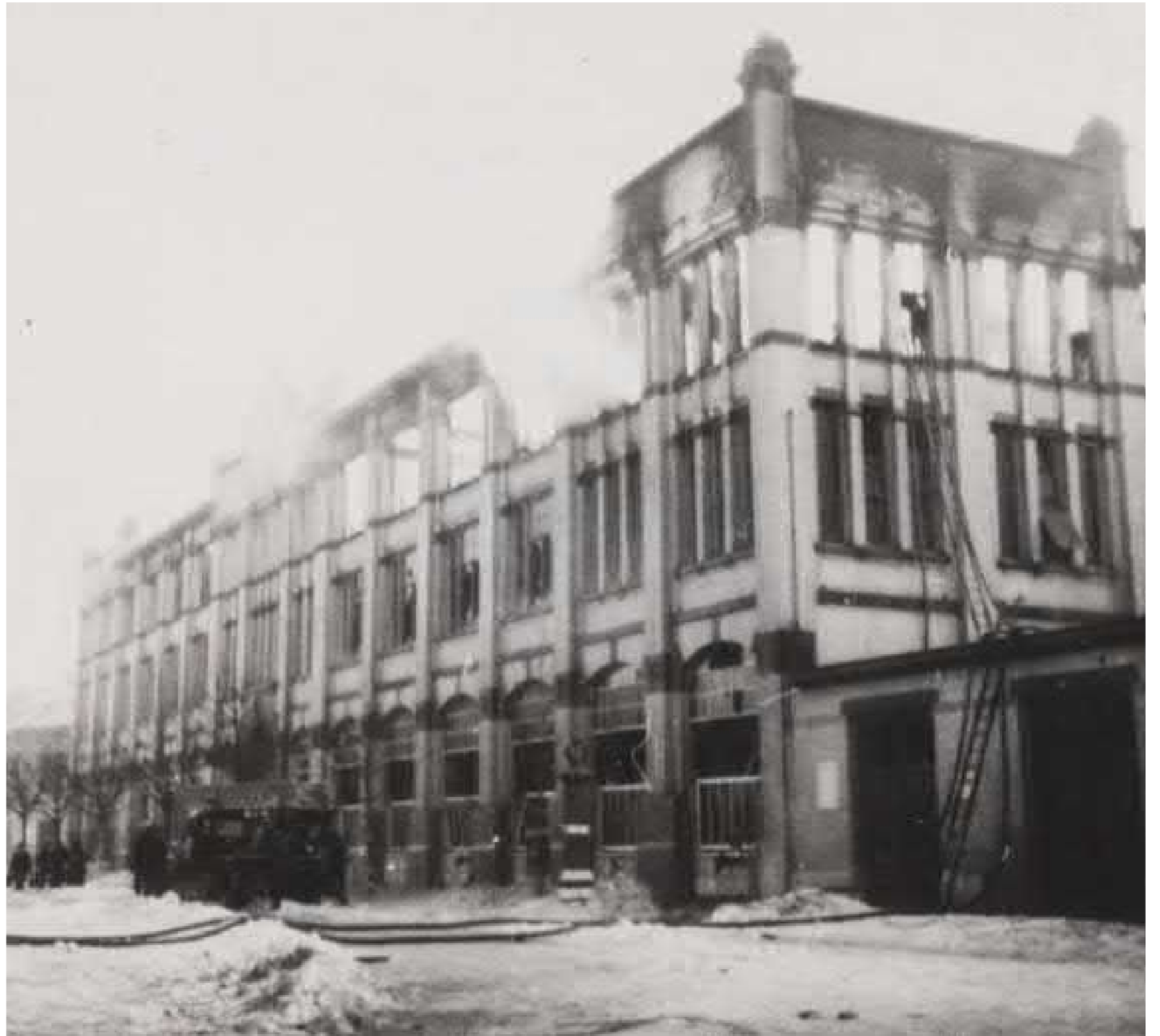
Schade aan het gebouw
