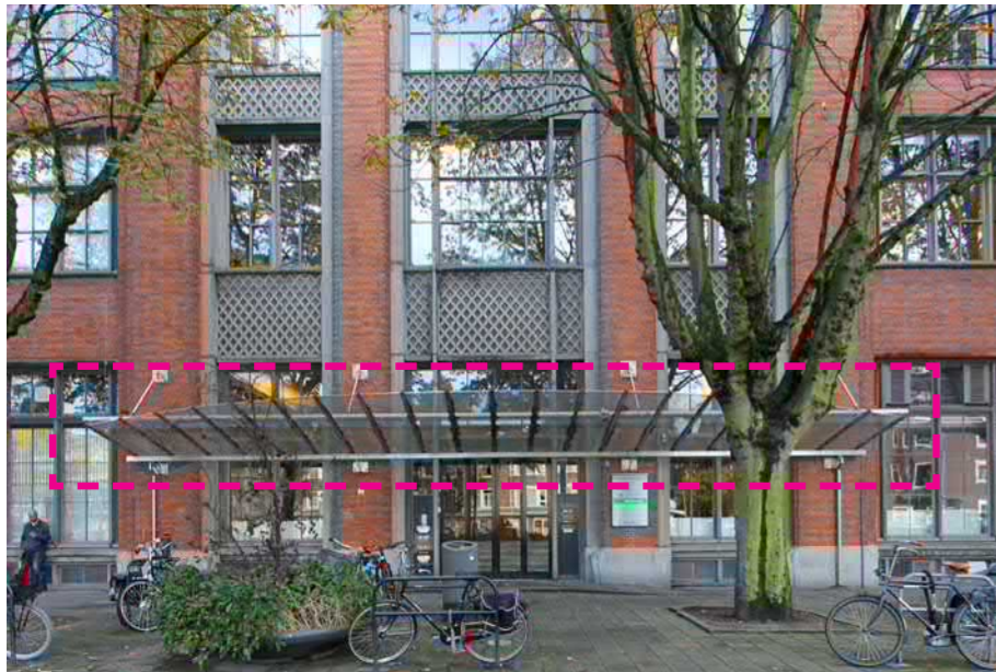
Toegevoegde luifels bij entrees van het Oceaanhuis | Mei Architects and Planners
