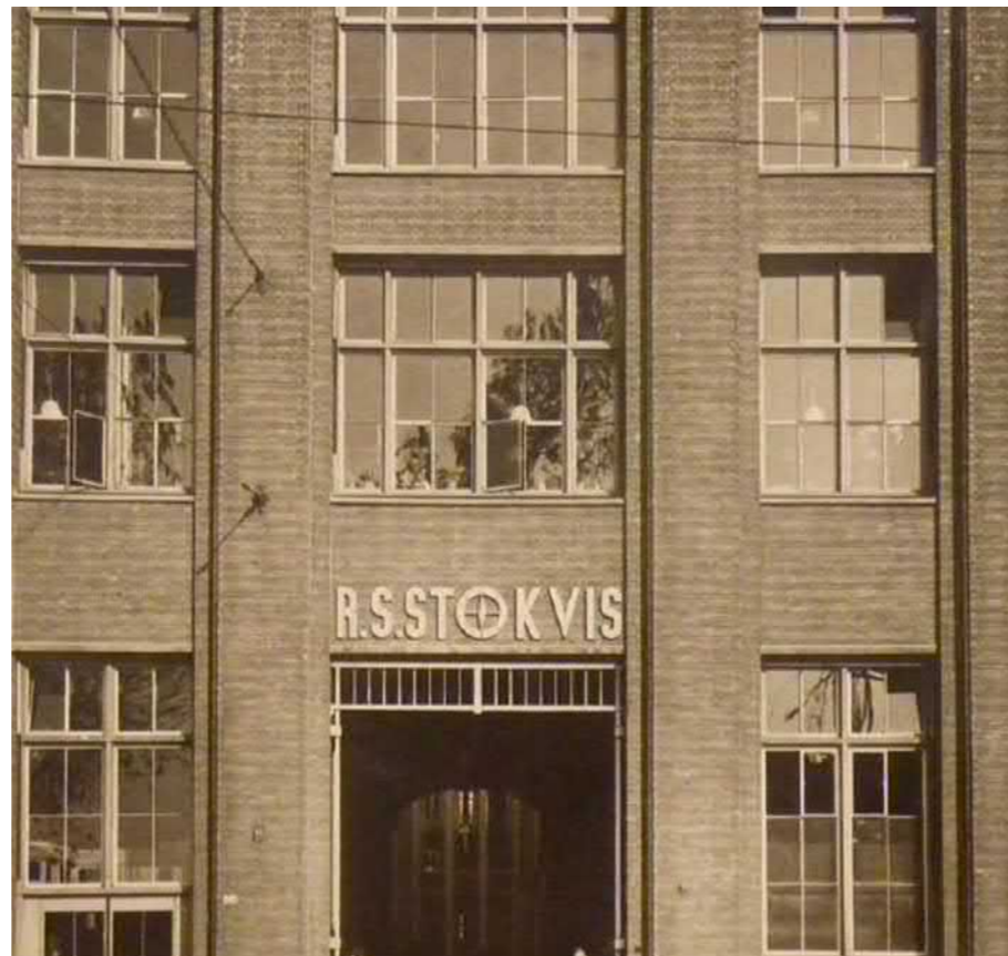
Zuidelijke ingang | SteenhuisMeurs, 15.12.2016
