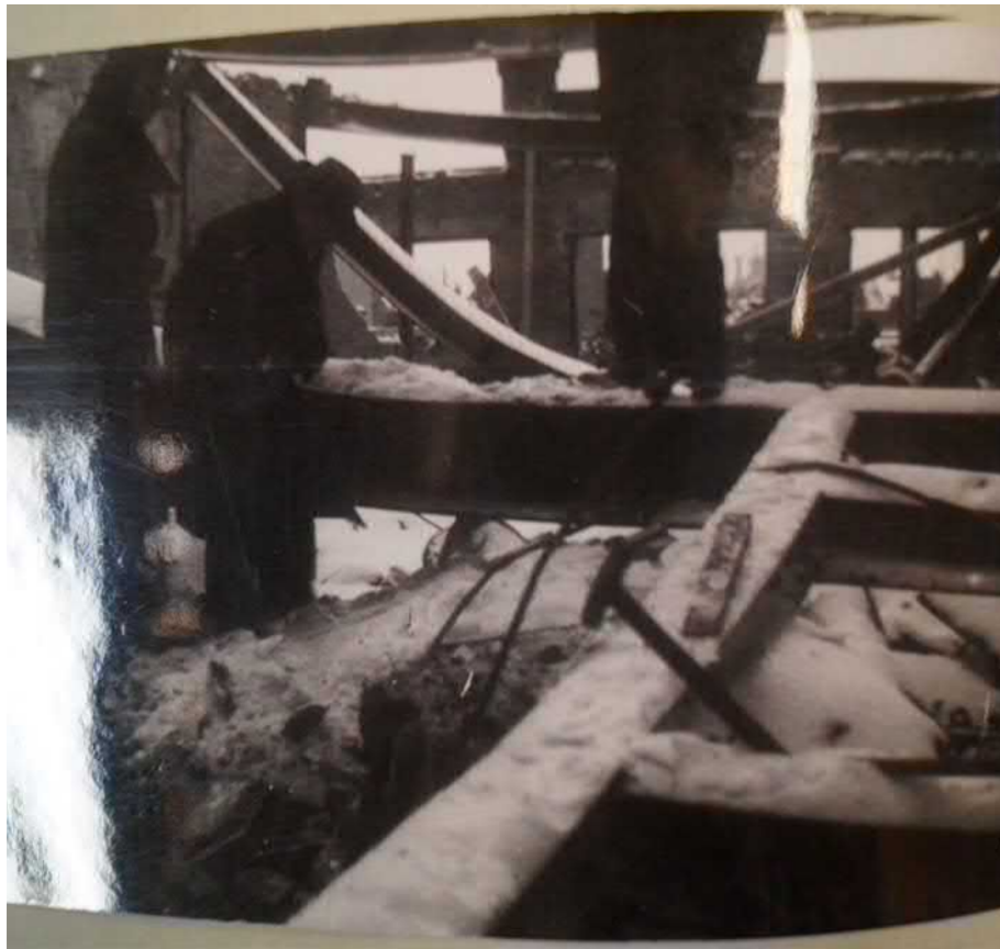
Schade aan het gebouw
