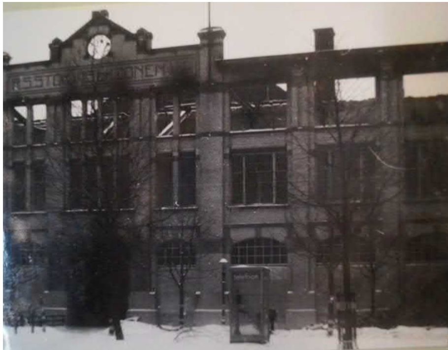
Schade aan het gebouw
