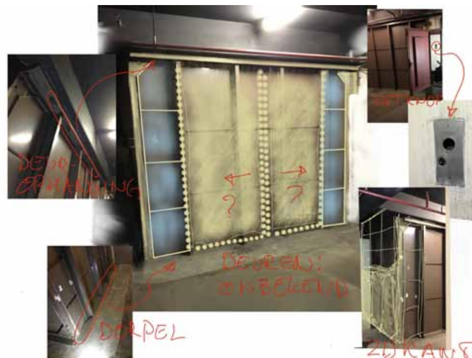
> afb 37 - Impressie van de oorspronkelijke uitmonstering van de liftschacht uit 1950 op kelderniveau, met ramen aan voor- en zijkant. De slijtdorpel en restanten van de deuropening zijn nog aanwezig, evenals de liftknop. De detaillering en de afwerking van de schuivende liftdeuren is onbekend.
