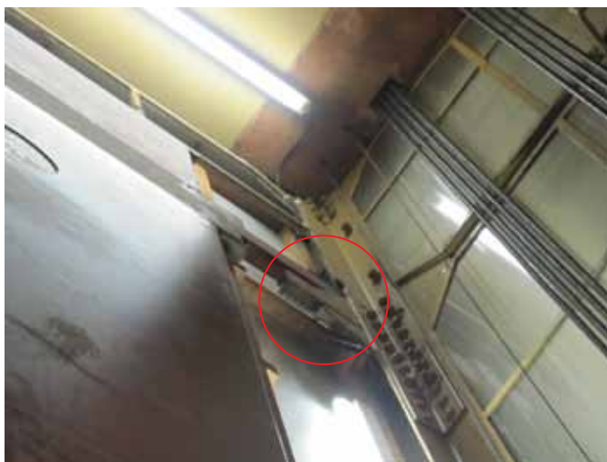
afb 27 - Afgezaagde raamstijlen op de tweede verdieping van de liftschacht, herbruikt om de nieuwe liftdeuren te verbinden aan de zijwanden van de schacht. Bovenin is nog een glasstrook over de gehele breedte van de liftschacht te zien, onder het met hout betimmerde dubbele plafond waarachter zich de hijskatrollen bevinden.
