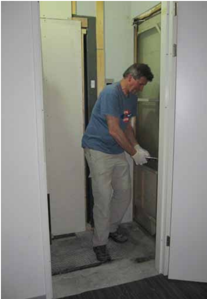
afb 30 - Aansluiting van de zijwand van de tussenruimte van de begane grond op de atriumgevel. De onderste ruit is gebroken. Daarachter de aansluiting van de gipsblokkenwand uit 1973 op de gevel.
