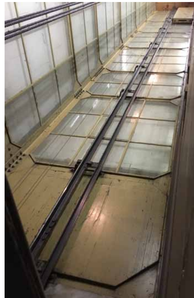
afb 38 - De linkerkant van de liftschacht aan de binnenzijde. Stijlen en regels van de schacht zijn verbonden met geboude knieverbindingen. Onderaan de betonnen atriumvloer met daarboven een metalen schopplaat tot aan het peil van de begane grondvloer. Bovenaan het plafond op dakrandhoogte en het contragewicht van de liftkooi. Rechts de recentere deurenwand uit 1959.
