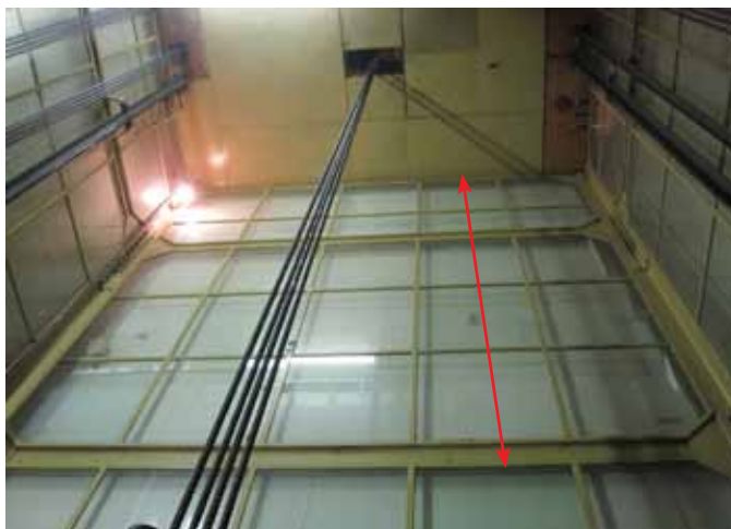
afb 26 - Binnenzijde liftschacht. Foto genomen vanaf de 1ste verdieping, met wandhoogte vanaf peil 2e verdieping tot onderzijde vloer.
