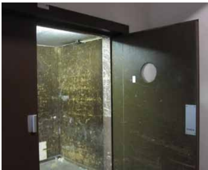
afb 24 - Liftkooi uit 1959 (binnenzijde later met hout bekleed) bij de kelderstop en met buiten- en binnenzijde liftdeuren
