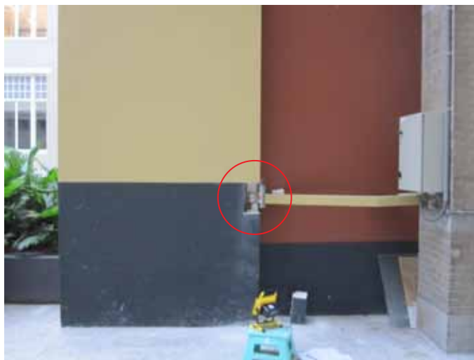
afb 16 - Onderzoekslokatie aan de rechterzijwand van de liftschacht ter hoogte van de eerste schoor. Het metalen schoorprofiel verdwijnt achter de gipsblokken en is verbonden met de liftschacht daarachter.
