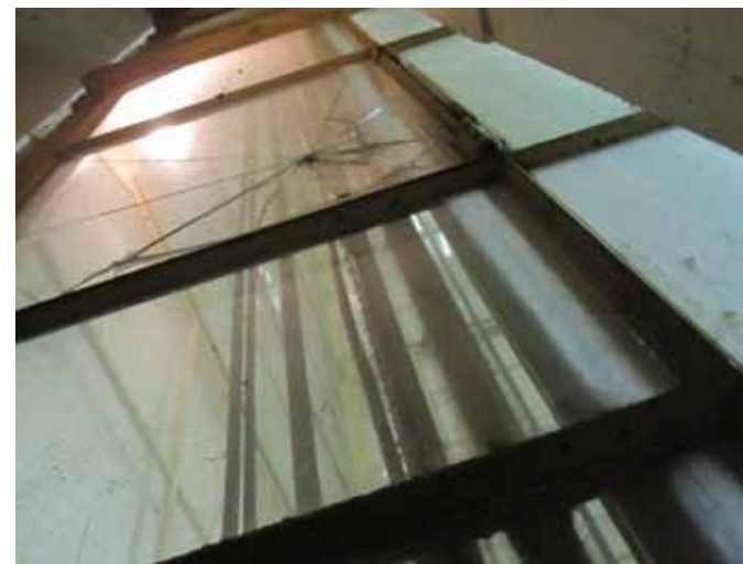
afb 18 - Zijwand van de liftschacht (exterieur) met doorzicht naar interieur van de schacht. De foto is genomen door een gat in de gipsbekleding dat voor het onderzoek is gemaakt. In het midden (met ruitbreuk) het draaiend raampje conform de tekening in afb 17.
