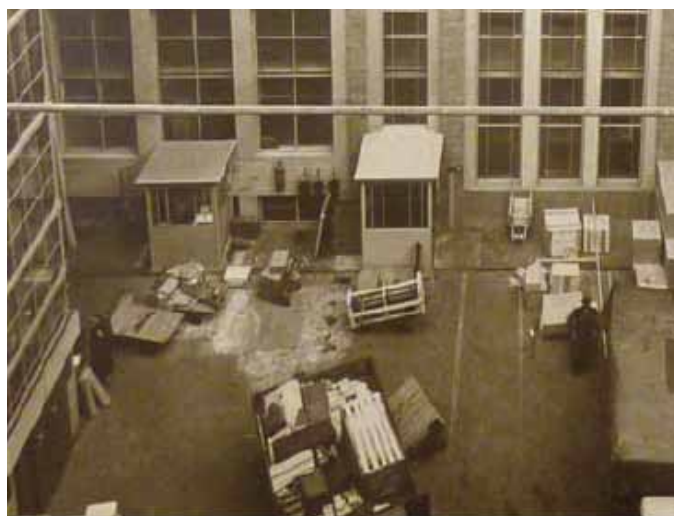
afb 13 - Het atrium met links de 'glazen lift' op een ongedateerde foto. Op atriumniveau zijn twee schuivende liftdeuren te zien. (foto: MEI historische foto's nr 17).
