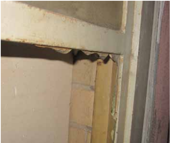
afb 30 - Aansluiting van de zijwand van de tussenruimte van de begane grond op de atriumgevel. De onderste ruit is gebroken. Daarachter de aansluiting van de gipsblokkenwand uit 1973 op de gevel.
