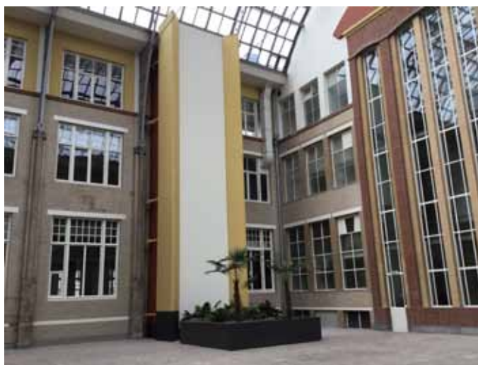
afb 19 - Huidige situatie van Goederenlift I, met omklede schacht. De schacht heeft twee puntvormen op de hoeken en aan beide kanten vijf geelgeschilderde metalen schoren van de Duyvis liftschacht.
