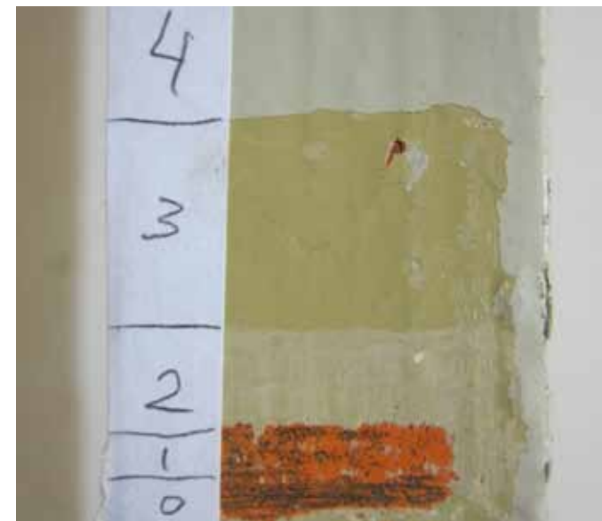
afb 32 - Lagenpakket op een glasroede van de ruimte van de eerste verdieping (interieurzijde). Op een menielag (1) is eerst een lichtgele afwerking in twee lagen aangebracht (2/3), daarna een lichte geelgrijze afwerking (4) (stratigrafie 2.16)
