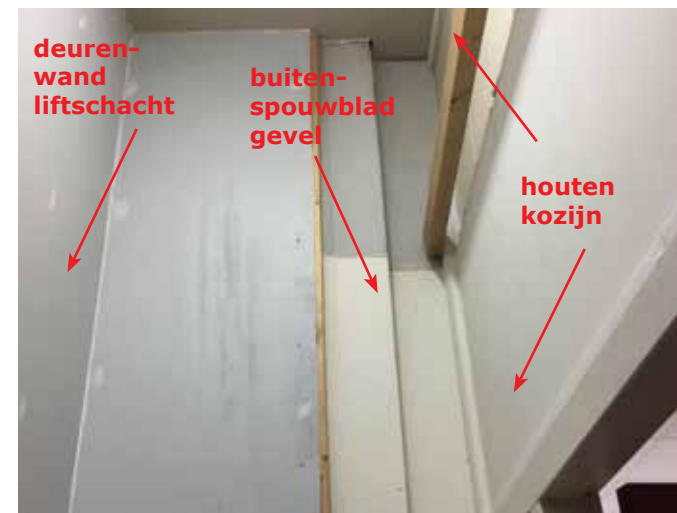
afb 10 - Houten kozijn met dubbele deuren achter een sparring van 320 cm breed (tussen de buitenspouwbladen) en met (vrijwel) de verdiepingshoogte.
