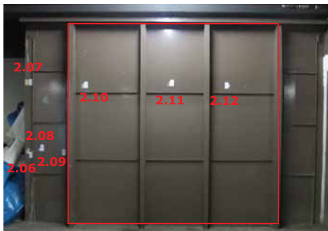
afb 35 - Hoekstijl liftschacht in kelder met op het metaal (0) een menie (1) en meerdere gele lagen (2-4), dan de grijze afwerking uit 1959 (5) en de bruine afwerking (6) die nu in het zicht is (stratigrafie 2.06)
