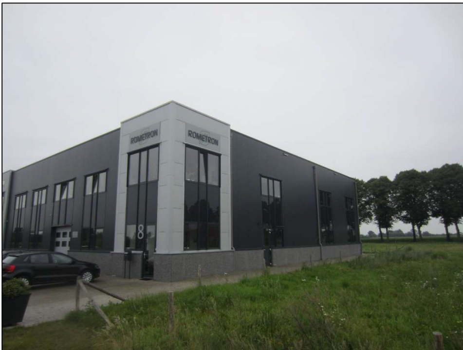
FOTO 2. ← BESTAAND BEDRIJFSPAND RECHTER ZIJGEVEL
