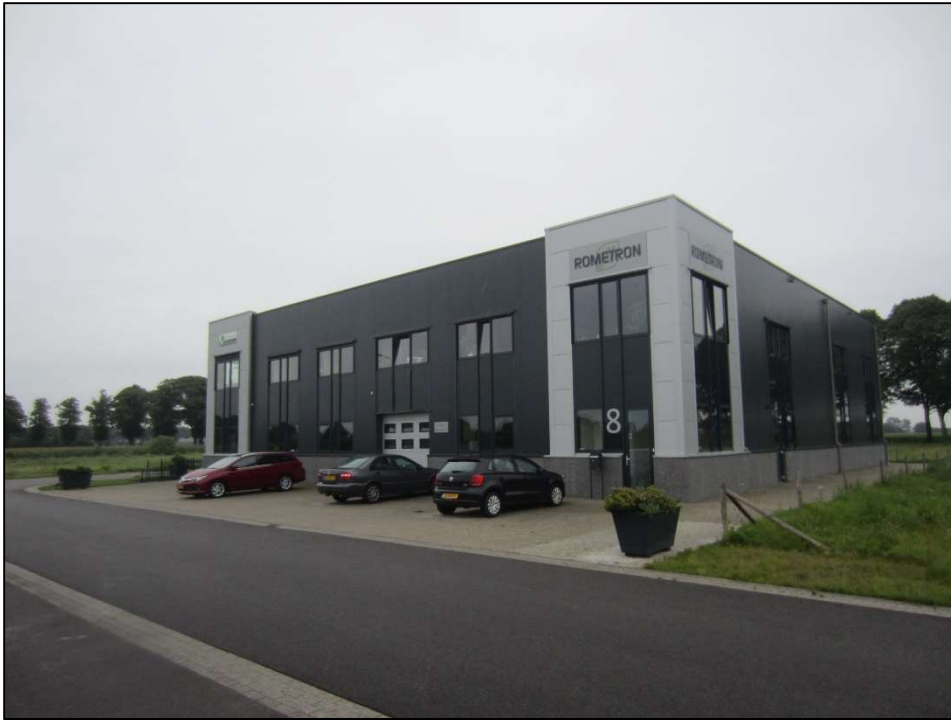
FOTO 1. ← BESTAAND BEDRIJFSPAND VOORGEVEL
