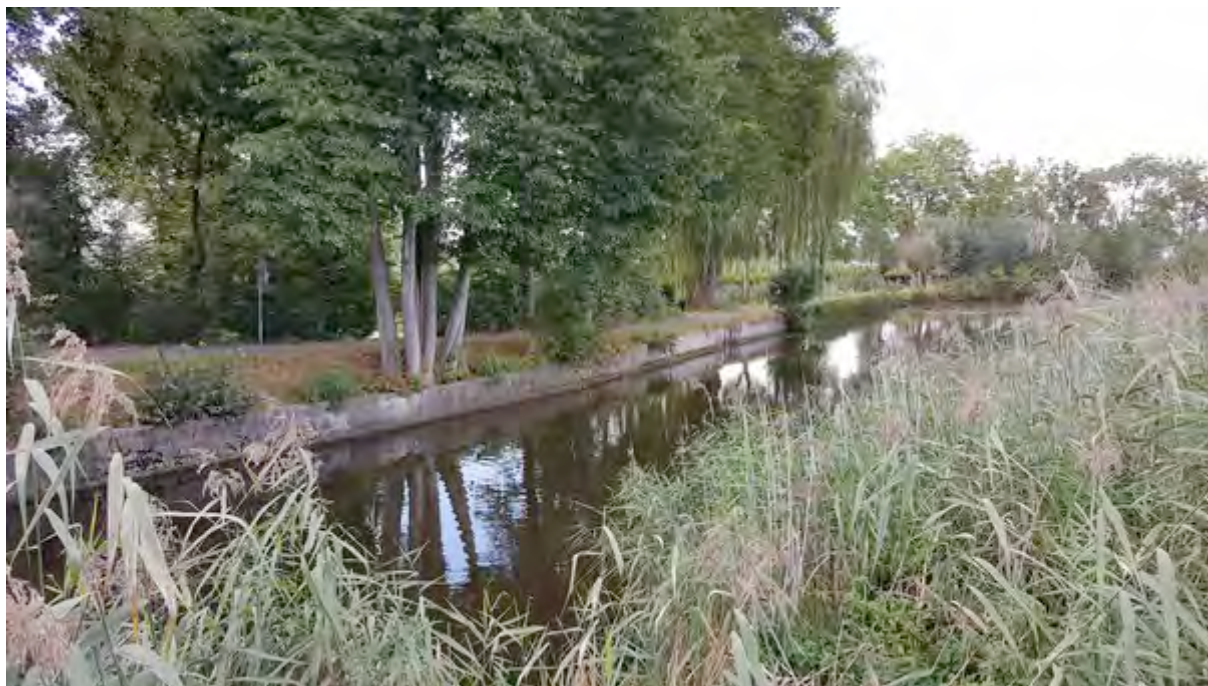
Overgang van de oever van de Giessen met oeverbeplanting naar betonnen grondkeringsconstructie
