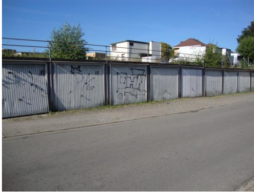
Garageboxen aan noordwestzijde projectlocatie
