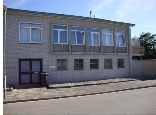
Woongebouw met bedrijvigheid (overzijde projectlocatie)
