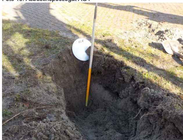
Foto 12: Asbestinspectiegat AG6
