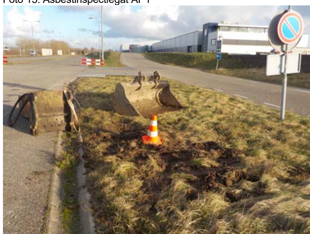
Foto 17: Asbestinspectiegat AP4
