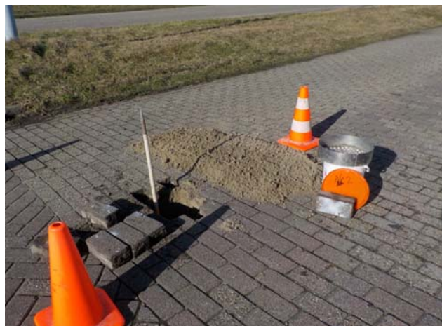
Foto 8: Asbestinspectiegat AG2
