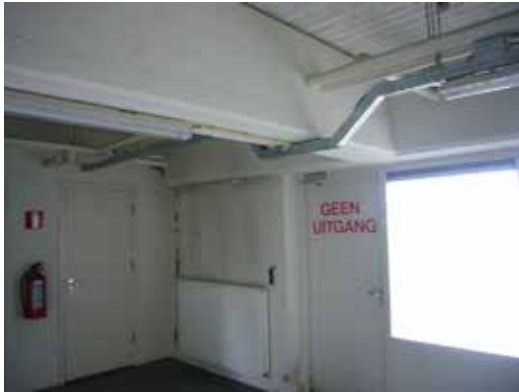
Zware betonnen liggers en plafonds scheiden de begane grond van de zolder.
