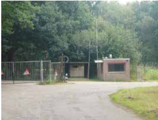
Vliegveld / centrum: voormalige toegang oostzijde naar PB-kamp: portiersloge, hek en personal shelter.
