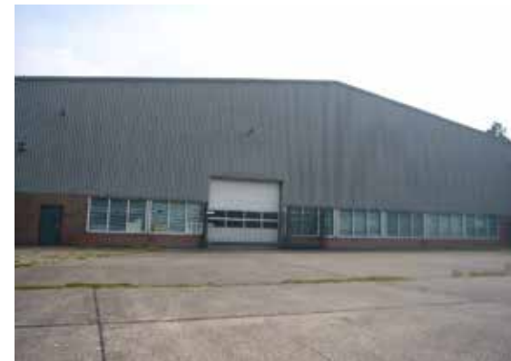
Vliegveld / centrum: hangar in cluster westzijde.
