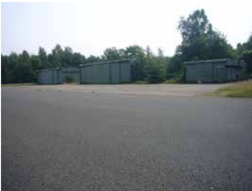
Vliegveld / centrum: aan de noordwestzijde ontwikkelde zich een cluster hangars, bunkers, werkplaatsen en kantoren.
