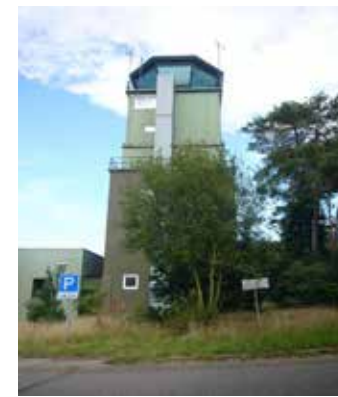
De verkeerstoren werd met een staalconstructie verhoogd.
