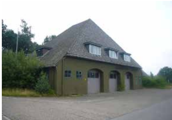
Camouflage architectuur, de betonnen brandweerkazerne is gecamoufleerd door de vorm van een Friese stolp boerderij.
