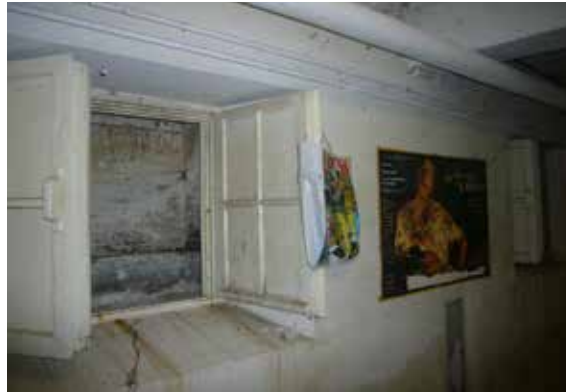
Voorbeeld van een schuilkelder die zich in veel panden/bunkers bevinden.
