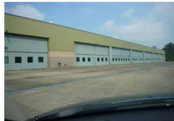
Grote hangar in cluster westzijde.
