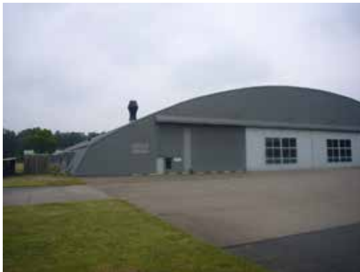
Vm. Oostkamp: moderne hangar met lichte gebogen vakwerkspanten.
