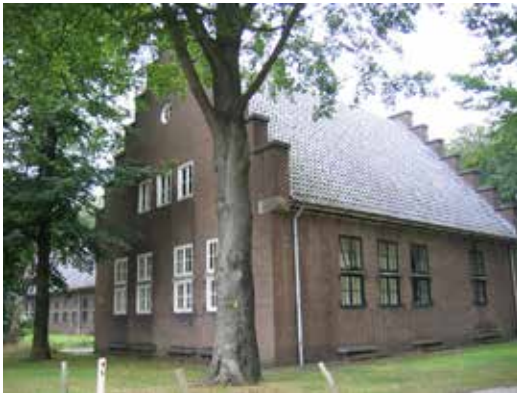
Camouflage architectuur, Oud Hollandse bouwstijl is op verschillende manieren toegepast om de bunker te verhullen.
