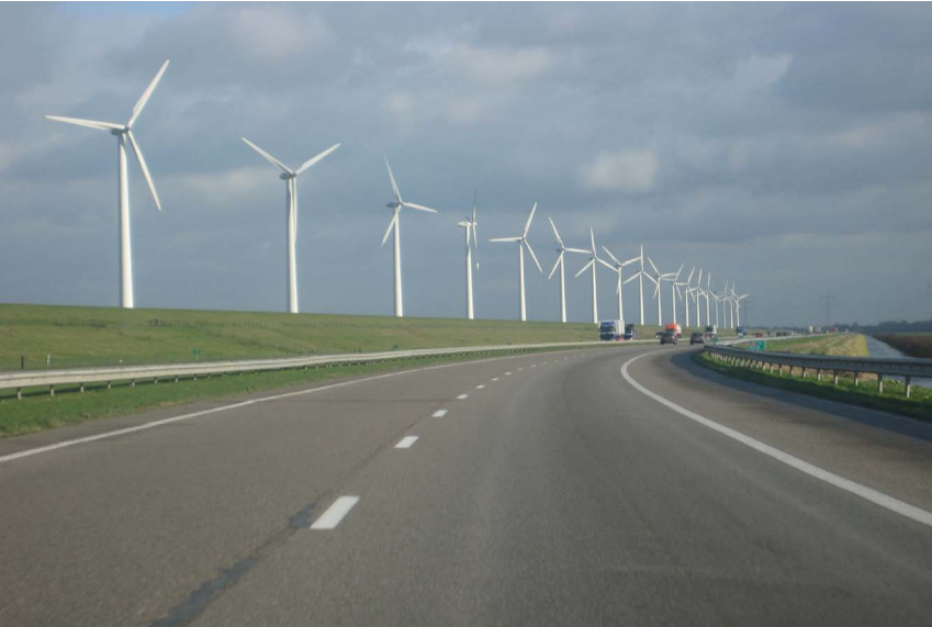
Windturbines begeleiden bocht A6 en IJsselmeerdijk, appeleren aan windrijk gebied IJsselmeer
