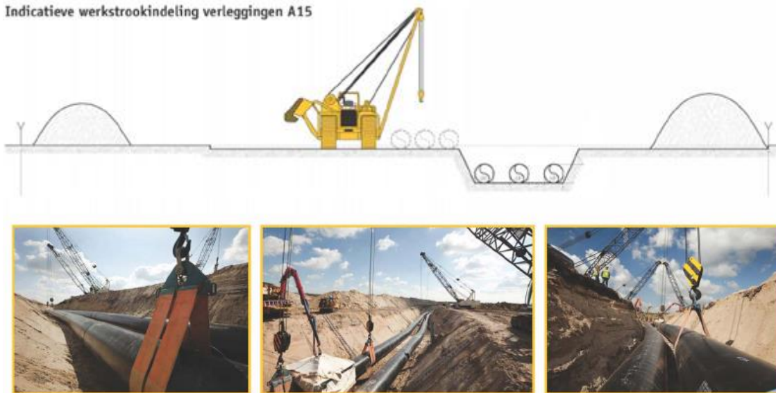
Figuur 6-1: voorbeeld van activiteiten op de werkstrook van planlocatie K1
